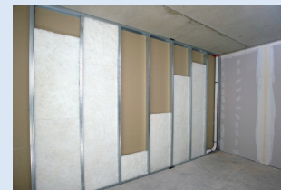
Trennwände mit Glaswolle: Leichtbau auch im Inneren eines Erweiterungsbaus.
