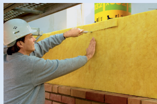
Massiver Anbau mit Kerndämmung und Backstein-Vorsatzschale.
