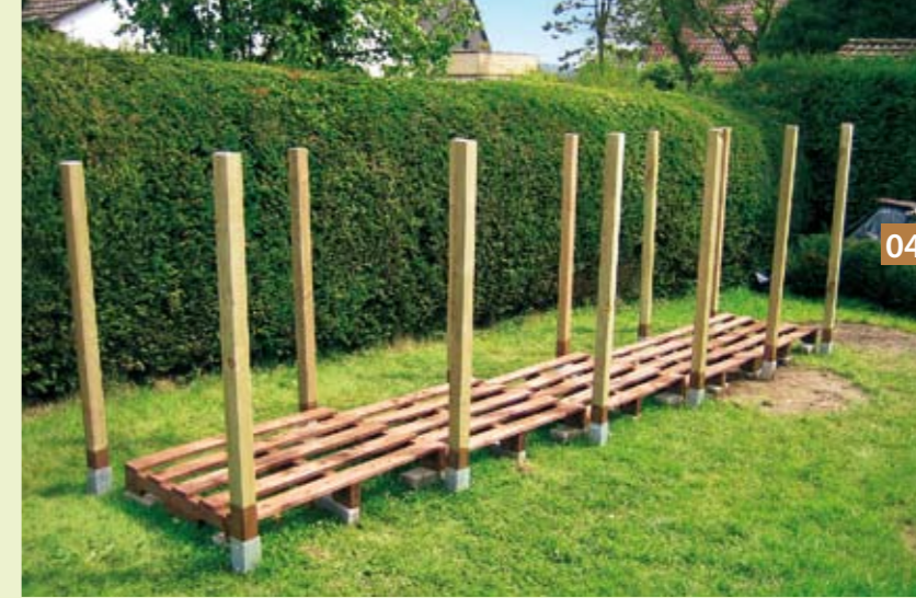
03 Entlang der Palettenreihe werden Einschlagbodenhülsen in die Erde geschlagen. Man bohrt erst mit einer Stahlstange vor.
