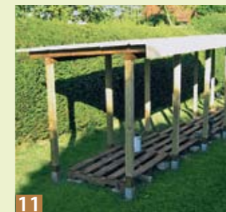
11 Vorn wird ein Stirnbrett angeschraubt, dann Dachpappe ausgerollt, um die Kanten gezogen und mit Pappnägeln angeheftet.
