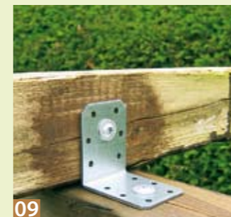
09 Die Sparren werden mit den Pfetten verschraubt. Hierbei kommen Schwerlast-Winkelverbinder zum Einsatz.
