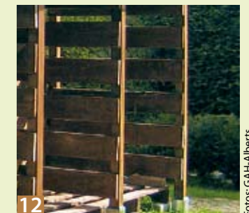
12 Mit Hilfe von Querbretern mit Lüftungsabstand wird der Unterstand stabilisiert und in große Fächer eingeteilt.
