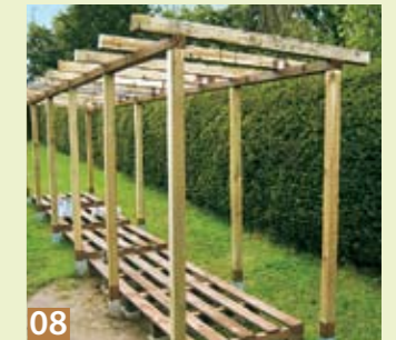
04 In die Hülsen im Abstand einer Palettenlänge werden Vierkanthölzer eingestellt, die man zuvor am unteren Ende imprägniert hat. Die hinteren Pfosten sind entsprechend dem gewünschten Dachgefälle niedriger.
