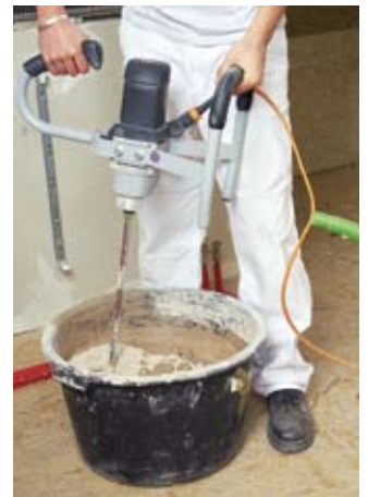
33. Der rötliche Grundputz „Fein“ wird so lange aufgerührt, bis er knollenfrei verarbeitbar ist.
