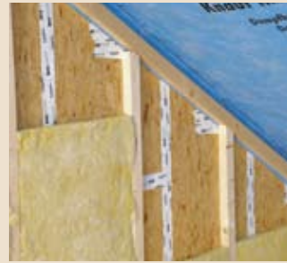
Dazwischen hat der Bauherr noch
