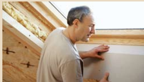
So kann man die Bauplatte einschieben und winkelig abklappen. Die Kartonbeschichtung muss bleiben!
