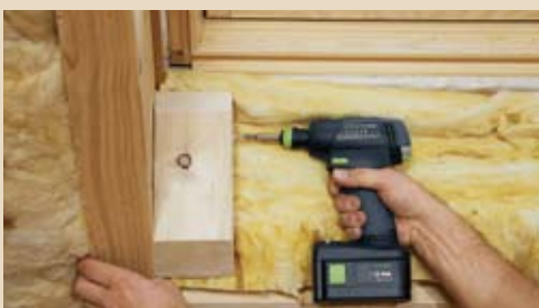
Auch unten braucht es entsprechende Hilfshölzer, damit die GK-Platten einen festen Halt bekommen.
