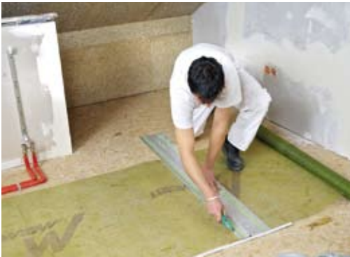
31. Vorbereitung vor dem Verputzen: Die Gewebepapierbahnen werden auf Länge geschnitten.
