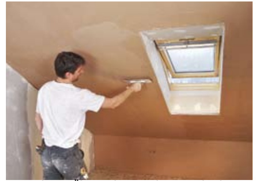
38. Ein dünner Überzug beseitigt letzte Unebenheiten, je nachdem, welche Endoberfläche man wünscht.
