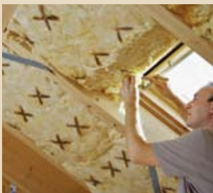
Den Dämmstoff oben und unten entsprechend zurechtformen.
