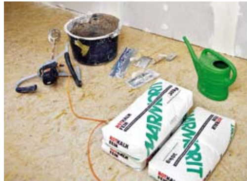
32. Die gesamte Dachschrägenfläche soll mit einem speziellen Kalkputz beschichtet bzw. gestaltes werden.
