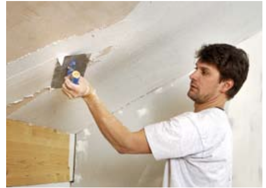
40. ... ermöglicht, wenn er nach dem Auftrag mit einem Schwamm Brett leicht nachgewaschen wird.
