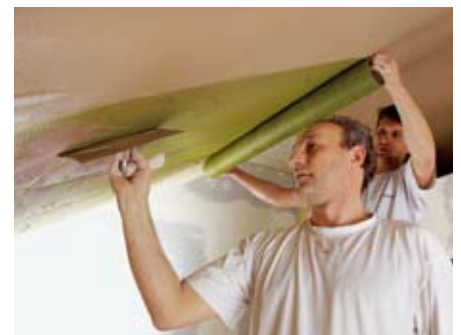
36. Die Gewebepapierbahn zu zweit einbringen: Einer hält die Rolle, der andere putzt sie unterhalb ein.
