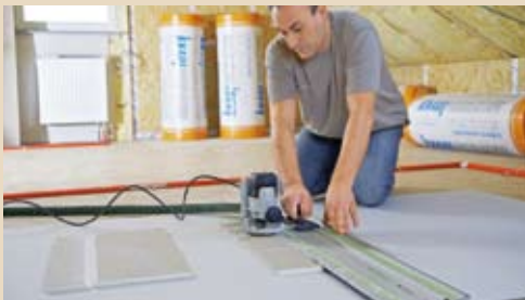
Aus 12,5 mm-Gipskartonplatten (GK) Stücke zurechtschneiden und mittels V-Fräser eine Nut ausarbeiten.
