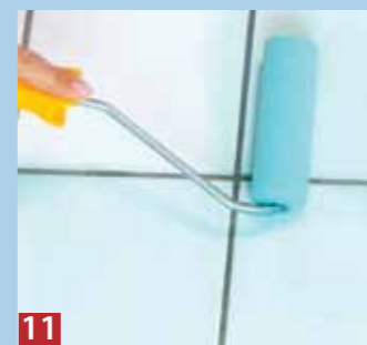
08 ...Trocknung wird Bad-Putz mit Bohrmaschine und Rührquirl langsam durchgerührt und einfach aufgerollt.
