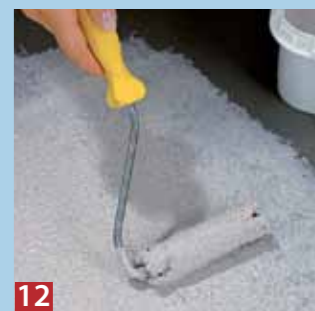
09 Auch in diesem Fall wird die Fläche zum Schluss durch ein bis zwei Anstriche mit der Schutz-Versiegelung geschützt.
