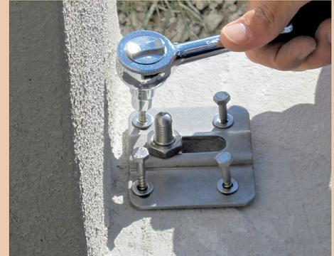
11. Mit vier Sechskantkopfschrauben und Unterscheiben wird die Dornplatte festgesetzt.
