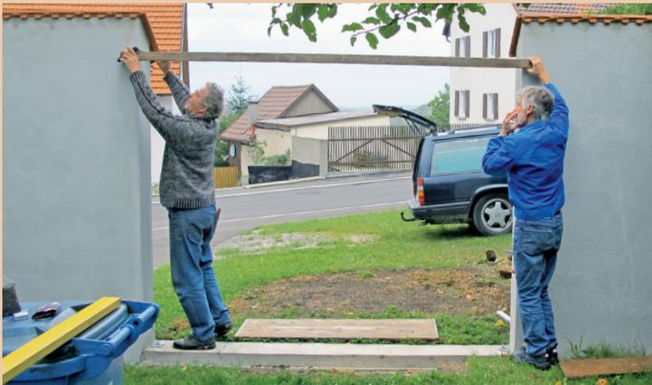
12. Erste Vorbereitung für die Flügelmontage: Zwischen den Mauerstücken wird eine Hilfsplatte mit Schraubzwingen fixiert, sodass das Tor nicht seitlich wegkippt.
