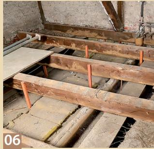
**06** Die Balken sind nun freigelegt und was dazwischen liegt, ist keine ausreichende Dämmung. Hier sollte man dann voll verfüllen.
