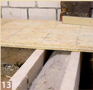
**13** Mit Hilfe einer Markierungslinie trifft man dann die Hochkantbretter genau mittig, was zur sicheren Befestigung beiträgt.
