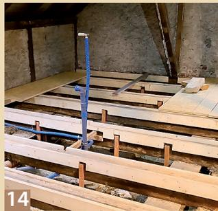
**14** Falls noch Leitungen verlegt werden sollen, lässt sich dies jetzt in den Zwischenräumen leicht erledigen, dann wird gedämmt.
