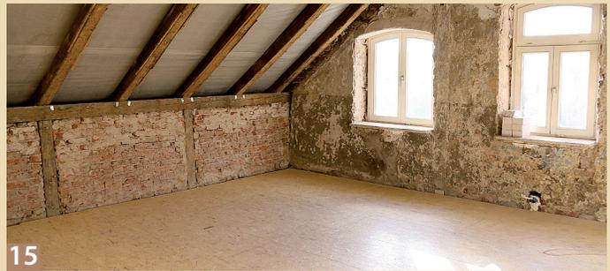
**15** Und so sieht der ausnivellierte Rohboden aus OSB-Platten dann aus. Er ist fertig für den weiteren Aufbau mit einer Trittschallkoppelung bzw. einer Trockenestrichlage und dem weiteren Oberboden nach Wahl. Hier dann stets darauf achten, dass Randdämmstreifen verlegt werden.
