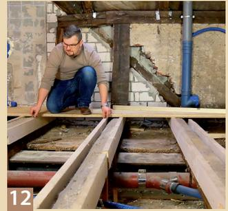
**12** ... verstärken so die Balken, geben mehr Dämmraum und sind dick genug zum Verschrauben des neuen OSB-Platten-Bodens.
