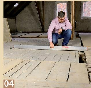
**04** Mit einem langen Richtscheit wird das Problem noch deutlicher sichtbar. Und sind die Bretter so stückig verlegt und ...
