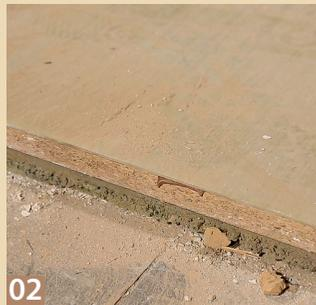
**02** In unserem Fall handelt es sich um einen Linoleumboden, verklebt auf OSB-Platten, die auf einer Trittschalldämmung liegen.
