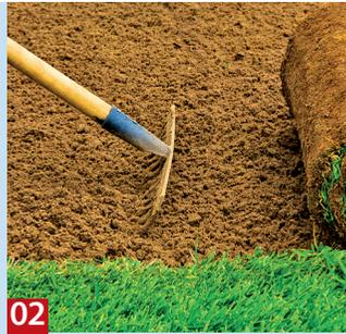
**02** Bei einer Erstverlegung muss der Boden vor dem Verlegen des Rollrasens ordentlich mit der Harke gelockert werden.
