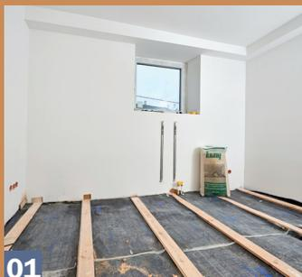
**01** Im sanierten Kellerraum fehlt nur noch der neue Boden. Der alte Holzbelag war morsch. Die neue Dampfsperre hilft gegen aufsteigende Feuchtigkeit.
