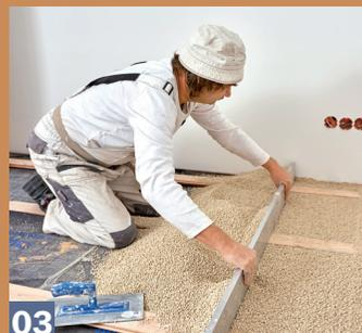
**03** Mit einem langen Richtscheit zieht man das zuvor grob verteilte Material bündig über der ausnivellierten Trag-Unterkonstruktion ab.
