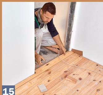
**15** Die letzte Reihe muss meistens in der Breite angepasst und bei Türdurchgängen entsprechend ausgeklinkt werden. Hier läuft der neue ...
