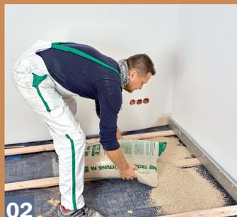
**02** Zwischen den vorhandenen und etwas breiter aufgedoppelten Tragholzern wird noch eine Trockenschüttung zur Wärmedämmung eingebracht.
