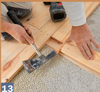
**13** Wenn Dielen leicht krumm sind, klopft man sie mit Keil und verschraubtem Reststück fugenfrei an die bereits liegende Dielen und verschraubt dann.
