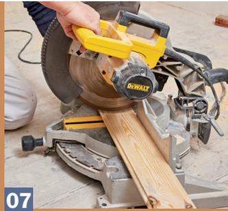
**07** ... die Sägelinie. Entsprechend wird von einer Langdielen das Kurzstück abgesägt – zum Beispiel mit einer Kappsäge. Der Dielenabschnitt ...
