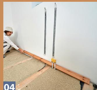
**04** Der langen Raumwand entlang kann dann auch schon die erste Dielle verlegt werden. Sie musste hier nur noch wegen der Heizkörperrohre ...
