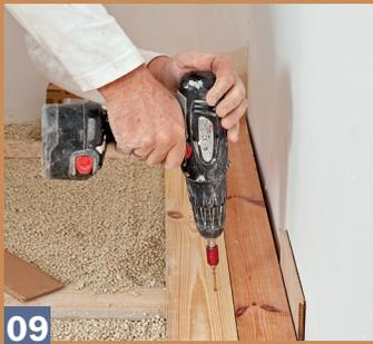
**09** Dort, wo die Dielen über ein Tragh Holz durchlaufen, werden sie mit zwei Schrauben fixiert. Die Schrauben dann nicht zu randnah und zu tief eindrehen.
