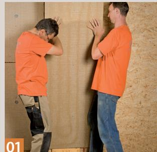
**01** Die Wandelemente werden im gewünschten Abstand (mindestens fünf Zentimeter) zum Boden auf ein Hilfsholz gesetzt ...
