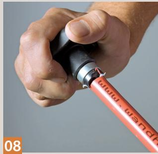
**08** Das zu verpressende Rohr-ende wird mit einem Kalibrier- und Fasenschneidwerkzeug aufgeweitet und angefast.
