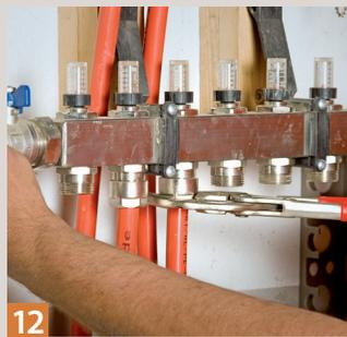
**12** ... an den Heizkreisverteiler angeschlossen. Nicht belegte Verteilerplätze werden mit Verschlusskappen abgedichtet.
