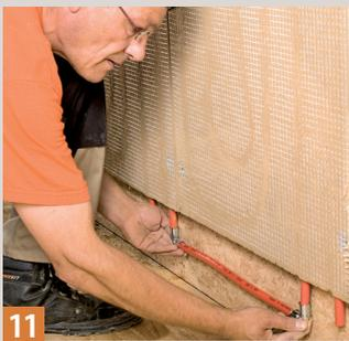
**11** Die einzelnen Klimatelemente werden mit Hilfe der vorbereiteten Rohrleitungen miteinander verbunden und dann ...
