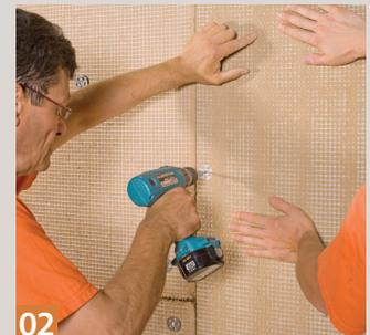
**02** ... und an den ab Werk in die Klimaelemente eingelassenen Halttellern an die Wand angeschraubt.
