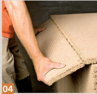
**04** ... ohne Rohr belegt. Dabei werden die Lehm- oder Gipsbauplatten durch Anritzen und Brechen auf das gewünschte Maß gebracht.
