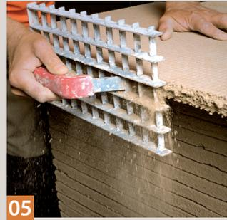
**05** Die Bruchkanten der Ausgleichsplatten aus Lehm- oder Gipsmörtel und Pflanzenfasern kann man z. B. mit einem Gitterraber säubern.
