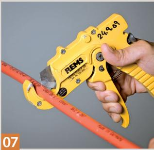
**07** Das WEM-Verbundrohr wird mit Hilfe einer Rohrschere abgelängt. Der Schnitt sollte genau rechtwinklig zur Rohrachse sein.
