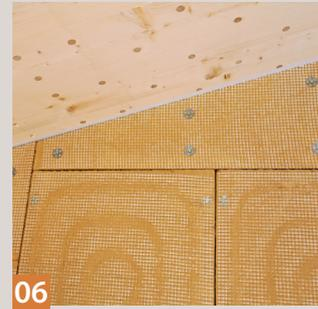
**06** Befestigt werden die gleichzeitig als Putzträger dienenden Ausgleichsplatten mit Senkkopfschrauben und Halttellern.
