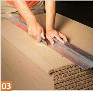
**03** Nach der Montage der Klimatelemente werden die restlichen Freiflächen auf der bearbeiteten Wand mit Lehm- oder Gipsbauplatten ...
