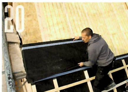
Die vierte Lage besteht aus Dämmplatten, die oberhalb der Sparren quer verlegt wurden.
