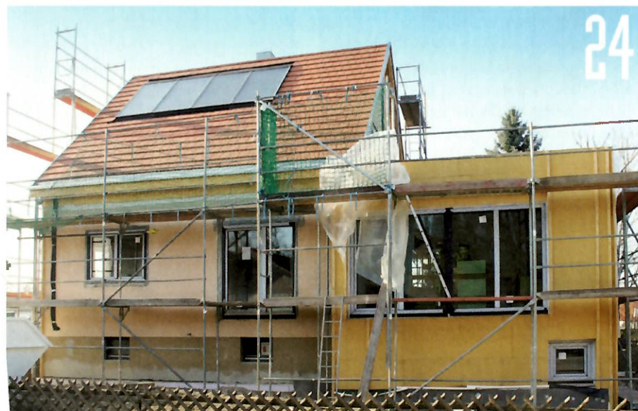
Das so im Dachbereich super energetisch modernisierte Haus wartet nun mit seinen neuen Fenstern und den zwei Anbauten in Holzbauweise auf die Dämmung der Altbaufassade.
