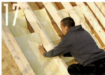
... die zwei ersten dünnen Dämmfilze stoßversetzt auf den OSB-Platten zu liegen kommen.
