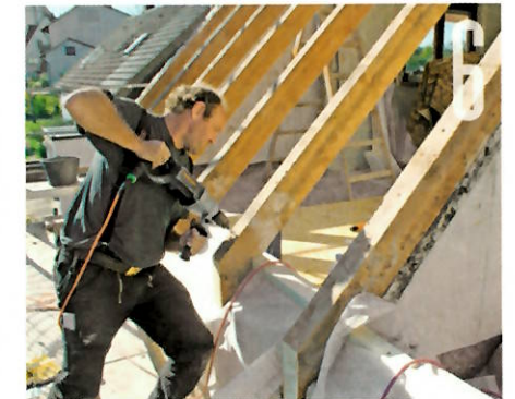
Die Fußpfette musste etwas erhöht werden, um die Sparren hier mit ihren alten Ausklinkungen aufsetzen und montieren zu können.
