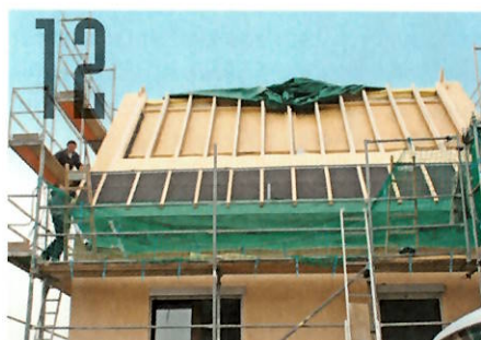
Mit OSB-Platten geschlossen: Jetzt wurden die Sparren aufgedoppelt und das Dämmen begann.
