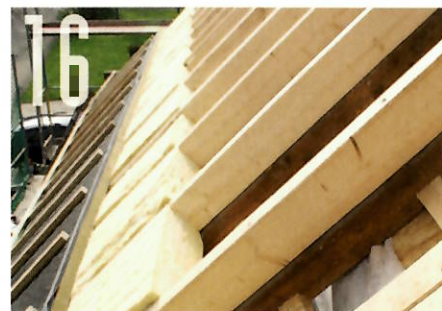
Blick über die neuen Sparren mit bündig eingebauten Zischensparrendämmungen, wobei ...
