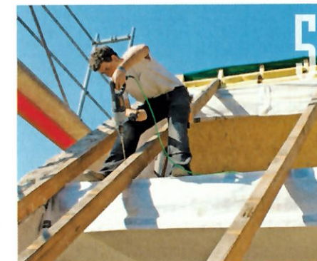
Die alten Sparren wurden neu ausgerichtet und an den Deckenkanten sowie am verstärkten First mit langen Schrauben fixiert.
