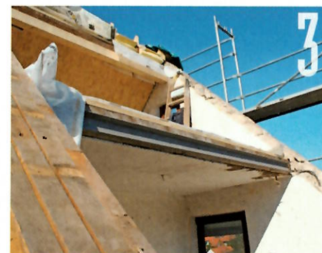
... ertüchtigt werden: So bekamen die äußeren Deckenbalken seitliche Verstärkungen in Form von U-förmigen Stahlträgern mit Auflager.
