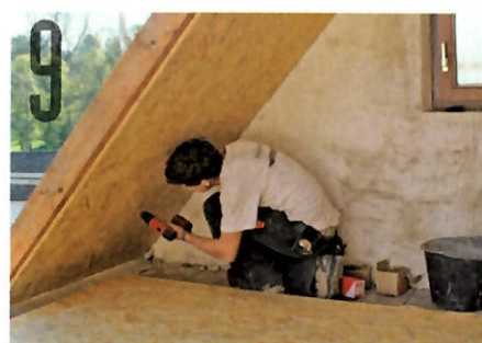
... konnte man auch die Platten anschrauben. In Sparrenmitte stoßen sie dann zusammen.
