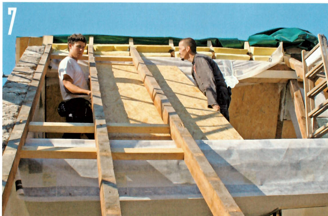
Nach drei festgeschraubten Sparren schob man gleich die ersten OSB-Platten von hinten an das Gebälk heran. Die Platten wurden bereits in der Zimmerei auf Maß geschnitten. Sie dienen als Aussteifungselemente und als Dampfbremse. Die weißen Bahnenabschnitte sorgen für flexible Übergänge bzw. Anschlüsse.
