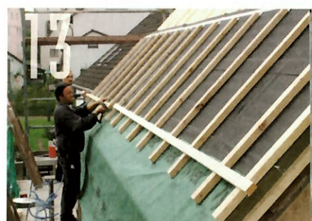
Unten ist schon ein Bereich fertig, sodass die ersten Latten als Steighilfe fixiert werden.
