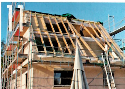
Hier noch einmal von außen: Die Sparren wurden nach und nach im Plattenraster verlegt.
