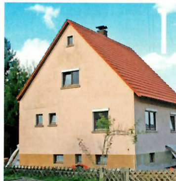
Das unscheinbare Häuschen soll zum Energiesparhaus werden. Und angefangen hat alles mit dem neuen Dach.
