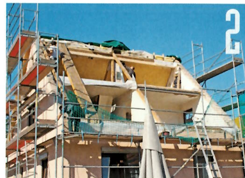
Die alten Dachflächen wurden abgedeckt, die alten Dachsparren erst einmal entfernt. Denn zunächst musste das Deckengebälk für die neue Situation ...
