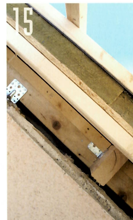
Zwei interessante Details: Links ein OSB-Plattenstreifen als Dachüberstandsbrett von der Traufe zum First, der bündig zur neuen Sparrenhöhe liegt.
