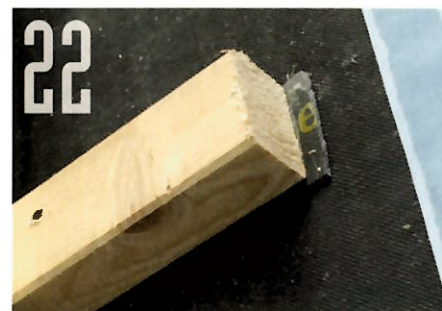
Die Konterlatten wurden auf Nageldichtband verlegt, was die Schraubenlöcher abdichtet.
