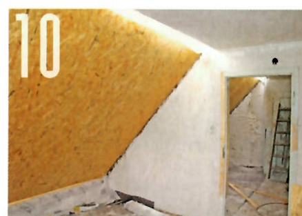
Und so schloss sich dann der Innenraum und war fertig für eine Gipsplatten-Bekleidung.
