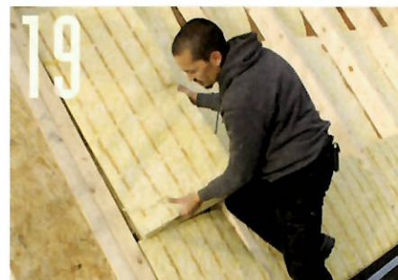
... und passten die Elemente dicht gestoßen und ohne Fugen zwischen die Sparren ein.
