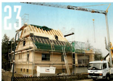
So schließt sich die Dämmung Richtung First. Das Vlies schützt übrigens auch vor Regen!
