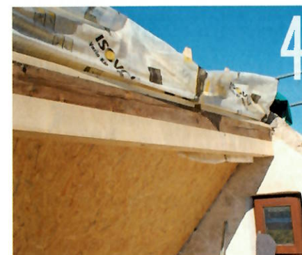
Die Firstpfette wurde mit Hilfe eines gehobelten Balkens gleicher Dimension „unterfütert“, um die Biegesteifigkeit zu erhöhen.
