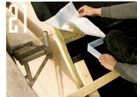
Ihre selbstklebenden Überlappungen sorgen für Fugenfreiheit und eine wind- und schlagregendichte Dämmhaut über dem Dachstuhl.
