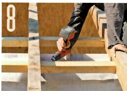
Zuvor steifte man die Sparren oben, unten und in der Mitte mit Kanthölzern aus. Hieran ...
