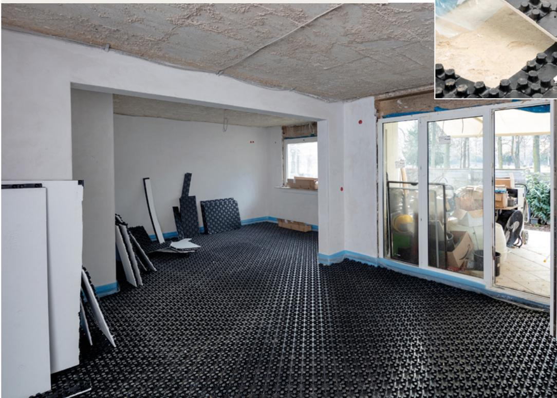
Eine Fußbodenheizung ist als Niedertemperaturheizung hervorragend für die Kombination mit einer Luft/Wasser-Wärmepumpe geeignet.
