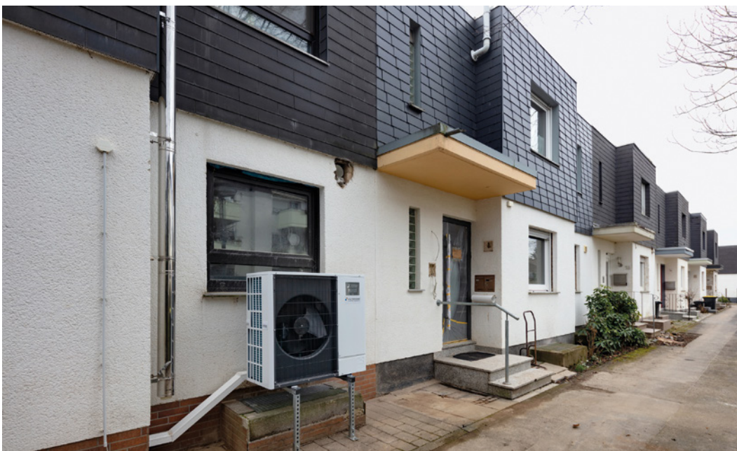
In Kombination mit einem Wärmedämmverbundsystem und neuen Fenstern weist das Reihenhaus einen geringen Energiebedarf auf, der optimal durch ein Luft/Wasser-Wärmepumpen-System abgebildet werden kann.
