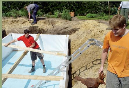
4. Zur Aussteifung und zur leichteren Folienverlegung hatte man sich Holzstreben gefertigt.
