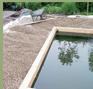
12. Die Kiesschicht deckt sie ab. Später liegt alles unter einem gemeinsamen Wasserspiegel.
