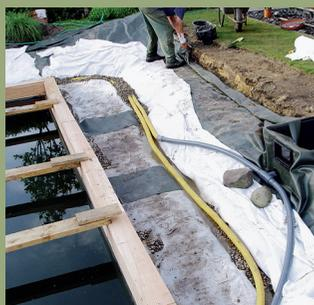
11. ... hier auch die Filterkreislaufrohre, die für die ständige Wasserumwälzung erforderlich sind.
