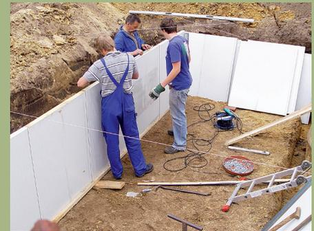
3. Die Beckenwände bestanden damals aus 6 cm dicken Blech-Sandwichplatten mit Nut und Feder.
