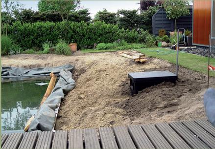
7. Der Randbereich drumherum wurde nach der Befüllung des Pools verfüllt und verdichtet.
