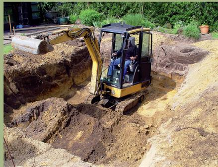
2. ... der Bagger loslegen. Die Baugrube ist wegen des Rechteckbeckens stufig angelegt.
