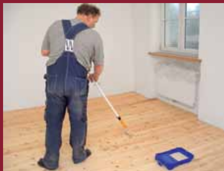
12. Die aus natürlichen Pflanzenölen, Balsamharzen u. a. bestehende Holzveredelung wird in Richtung der Holzmaserung aufgewalzt.
