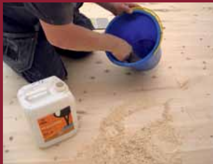
9. Vorhandene Fehlstellen lassen sich mit einer Mischung aus Schleifstaub und einer Kittlösung ausbessern. Das Material wird mit einer ...
