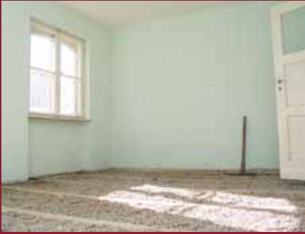
1. Ausgangszustand: Klassische Holzbalkendecke mit Fehlboden und Fehlbodenschüttung. Diese wurde gefachweise entfernt.
