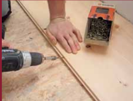
6. Die Dielen werden dabei mittels Dielenschrauben mit eigener Bohrspitze schräg durch die Feder (Winkel zirka 45 Grad) fixiert.
