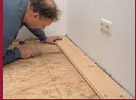
3. Für eine gleichmäßig geschlossene Anschlusskante wird die erste Diele mit Hilfe einer Richtschnur fluchtgerecht ausgerichtet.
