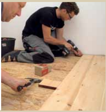
4. Zur Vermeidung einer Schallbrücke wird das erste Brett mit einem Wandabstand von einem Zentimeter mit den OSB-Platten verschraubt.
