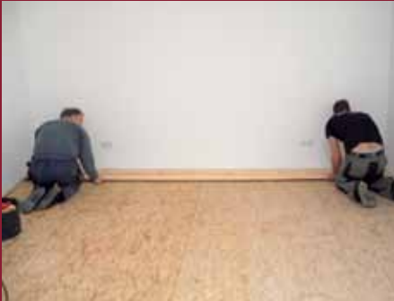
5. Danach folgen die weiteren Bretter (ein Verkleben der Dielen ist nicht ratsam, da diese „arbeiten“, und nicht dauerhaft halten würden).
