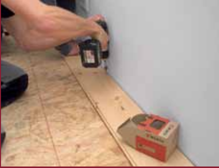
4. Zur Vermeidung einer Schallbrücke wird das erste Brett mit einem Wandabstand von einem Zentimeter mit den OSB-Platten verschraubt.
