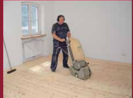
7. Für eine glattere Oberfläche des fertig verlegten Bodens werden dann die sogenannten Hobelschläge noch maschinell abgeschliffen.
