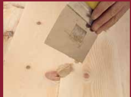
10. ... Spachtel in die Vertiefungen gedrückt. Nach Trocknung wird die ganze Fläche dann noch ein weiteres Mal geschliffen.
