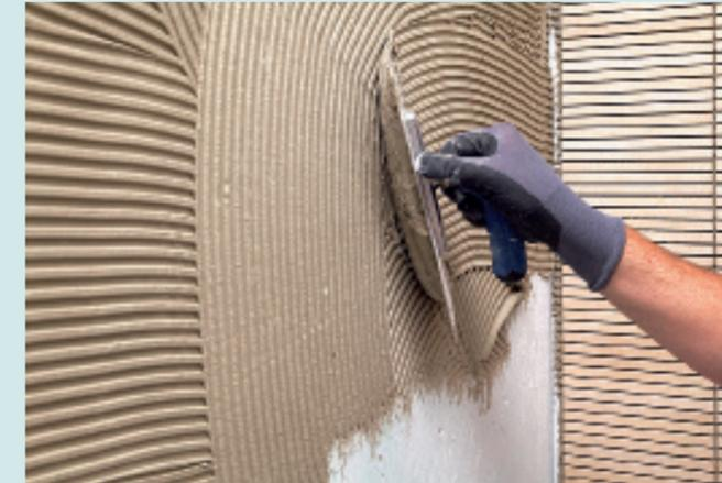
1. Die Wannenummauerung aus Porenbeton erhielt – da stark saugend – eine Grundierung, dann erst wurde der Fliesenkleber aufgekämmt.
