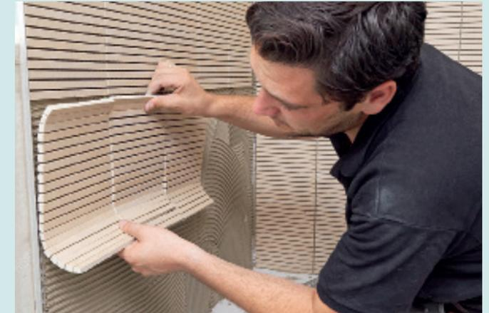
2. Die auf einer Tafel aufgetragenen Keramikstäbe im Dreierpack werden ins Kleberbett gedrückt. Wichtig bei einem hohen Fugenanteil ist, dass ...
