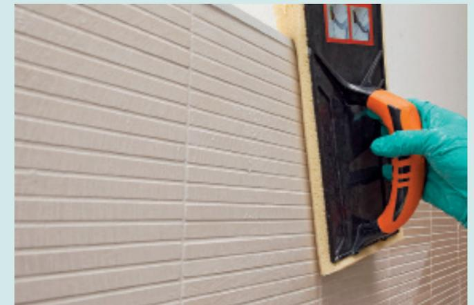
8. Mit der fast Ton-in-Ton-Verfugung geben die stabverfliesen Flächen eine harmonische Gesamtansicht ab – bei gleichzeitig dezenter Reliefstruktur.
