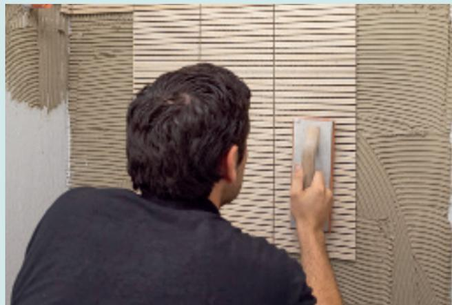
4. Hilfreich ist es, wenn mit der Unterstützung durch ein Schwambrett die Stäbe auf Oberflächenbündigkeit überprüft bzw. nachgedrückt werden.
