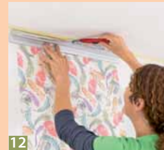
08 Die erste Bahn wird mit Überstand zur Decke an der senkrechten Markierung angelegt und in der Tapetenmitte angedrückt.
