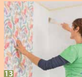
09 Bei Bedarf noch etwas korrigieren und anschließend die Bahn mit der Tapetenbürste von innen nach außen feststreichen.
