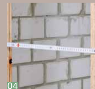
04 Das Deckenprofil anbringen und dann die Ständer zwischen Boden- und Deckenholz einsetzen und lotrecht ausrichten.
