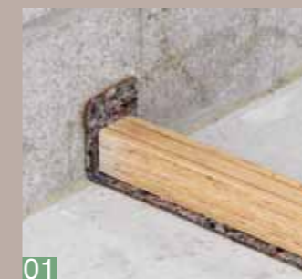
01 Den Wandverlauf an Boden und Decke anzeichnen, auf das Holzständerwerk 50 mm breite Randdämmstreifen aufkleben, ...
