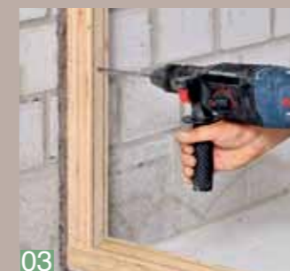
03 Das vorbereitete Wandprofil aufstellen, ausrichten und jeweils im Abstand von maximal 1000 mm an der Wand befestigen.
