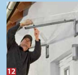
**12** Schließlich kann man die Kunstglasplatte mit Hutschrauben und Kunststoff-Unterlegscheiben auf den Tragkonsolen montieren.
