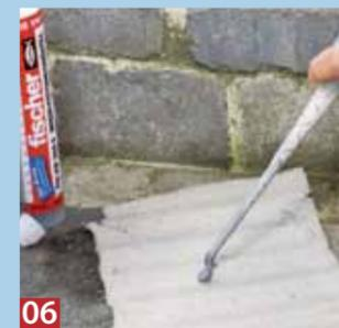
**06** Der Klebemörtel wird durch einen Statikmischer ausgepresst. Das anfangs austretende Material wäre dies nicht nötig.
