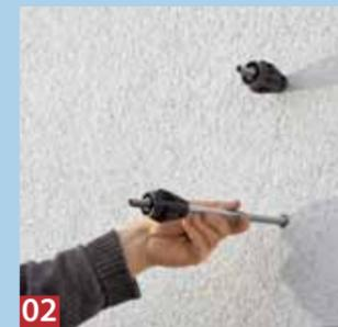
**02** Die auf Wunsch abgelängte Gewindestange wird vollständig in den Anti-Kälte-Konus eingedreht und dann in das Bohrloch gesteckt.
