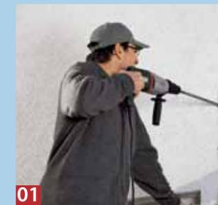
**01** Sind die Bohrpunkte ermittelt, werden die Löcher gemäß Montagedatentabelle gebohrt – bei Lochstein ohne Schlagwerk.
