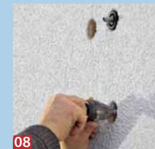
**08** Leicht drehend führt man die Gewindestange so tief ein, dass der Konus einen Millimeter über der Putzoberfläche vorsteht.
