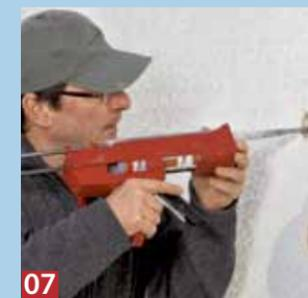
**07** ... dann wird die Ankerhülse vom Bohrlochgrund aus blasenfrei mit Injektionsmörtel (Menge entsprechend der Tabelle) verfüllt.
