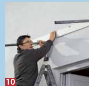
**10** Mit Hilfe von Maßstab und Richtscheit werden die Bohrpunkte für die zweite Konsole ermittelt. Mit vier weiteren ...
