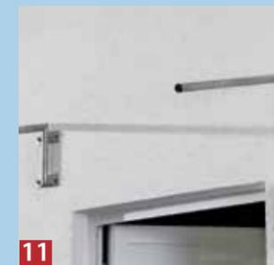
**11** ... Einheiten des Abstandsmontagesystems wird auch der zweite Dachträger thermisch getrennt in der Wand verankert.
