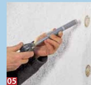
**05** Mit der Gewindestange wird nun die Injektions-Ankerhülse gesetzt. Bei einer Wand aus Vollstein wäre dies nicht nötig.
