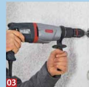
**03** Mit Hilfe eines Sechskant-Bits wird der Konus bündig in die Wärmedämmung gefräst. Hierbei ist das Schlagwerk eingeschaltet.
