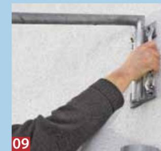
**09** Nach dem Aushärten des Mörtels wird die Fuge rund um den Konus mit Dichtkleber verfüllt, dann die Konsole montiert.
