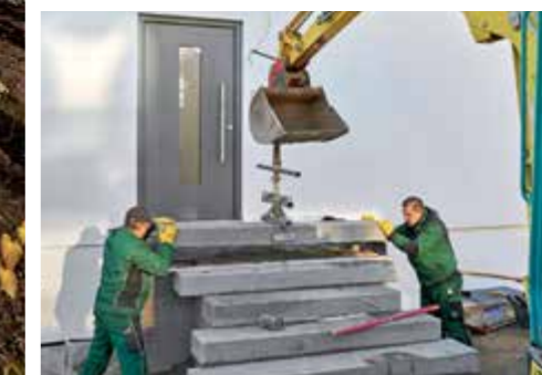
4. Per Bagger und Hebewerkzeug waren die schweren Stufen leicht zu manövrieren und an Ort und Stelle abzusetzen.
