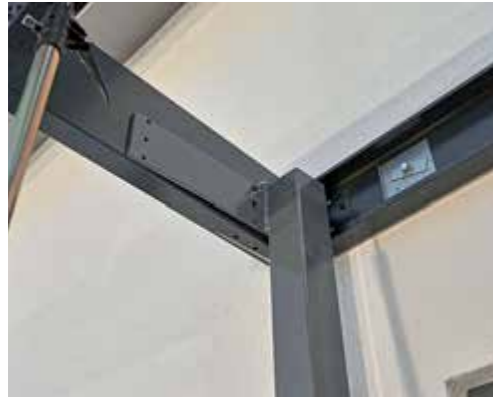
17. So sieht dann die provisorische Befestigung von innen gesehen aus. Eine Schraube sitzt und hält die Stütze auf Höhe, sodass man nun am Boden den ...
