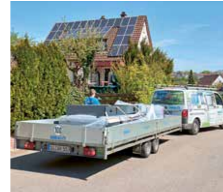
8. Und dann war es endlich soweit – die Bauteile für die Eingangsüberdachung wurden pünktlich und bei bestem Wetter per Hänger angeliefert.
