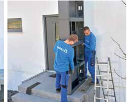
10. Und auch der Plattenleger hat sich exakt an die Grundmaße des Bauteils gehalten, sodass das konstruktive Innenleben darstellt.
