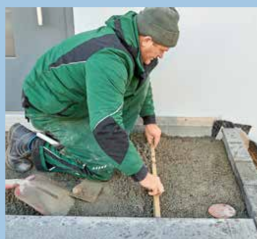
5. Das obere Podest wurde zwischen dem Rand des Stelen-Unterbaus und der oberen Stufe aufgefüllt und so hoch glattgezogen, dass der Plattenbelag bündig abschließen konnte. Rechts der Anschluss fürs Fallrohr.
