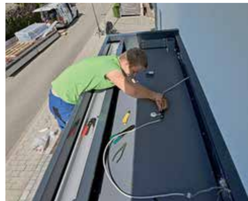
28. Da hier eine Deckenbeleuchtung gewünscht war, wurden vor der Montage zwei Lochbohrungen in der Platte erstellt. Jetzt sitzen hier Einbau-Deckenspots, die nur noch verkabelt werden mussten.
