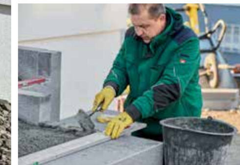
3. Ein leicht erhöhter Mörtelrand sorgte für eine satte, hohlraumfreie Verklebung der Stufen.
