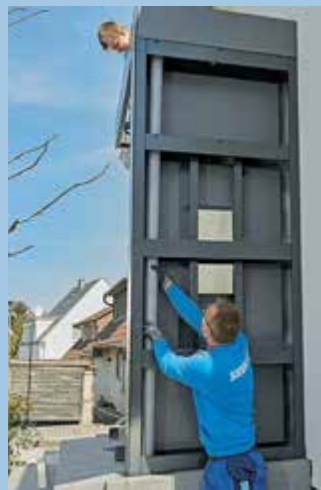
23. Zuerst wird das Fallrohr in zwei Teilen eingeführt, zusammengesteckt und unten am Podestboden ans Kanalrohr angedockt.
