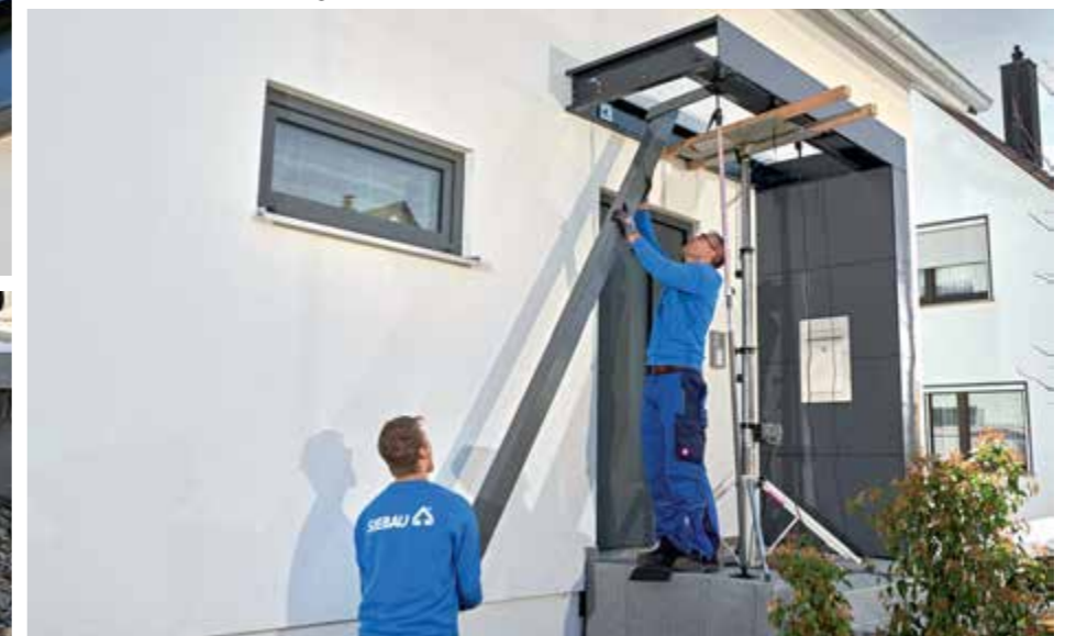
16. Am Stahlpfosten selbst wurde oben schon werkseitig eine stabile Montagelasche angeschweißt. Die Stütze wurde dann so eingebracht, dass sie nachfolgend von innen her am Dachteil-Rahmen angeschraubt werden konnte. Dazu wurde die Außenverkleidung am Querrahmen abgeschraubt.
