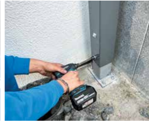
20. Und jetzt lassen sich auch der Stützenfuß im Boden verankern sowie die Feststellschrauben seitlich am Pfosten festdrehen.
