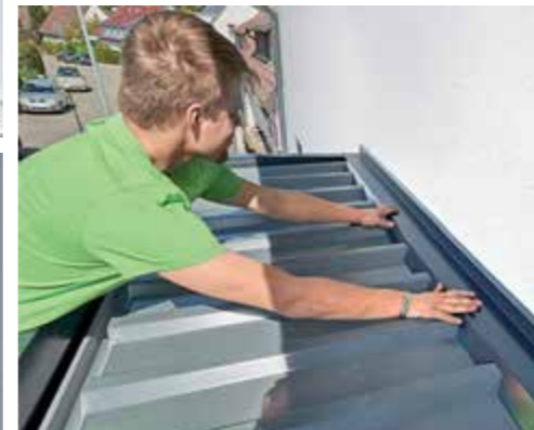
30. ... sorgen sie für eine direkte Wasserableitung in die Rinne. Hinten sorgt ein entsprechend ausgeformtes Winkelblech für den sauberen Anschluss an der Fassade. Eine Acrylfuge bringt Regendichtheit.
