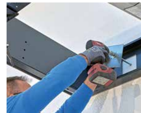
14. ... losgelassen werden konnte, setzte ein Monteur den Dachrahmen mit Hilfe einer Montageplatte und einer langen, dicken Holzschraube fest, die in der Holzrahmenkonstruktion der Fertighauswand Halt fand.
