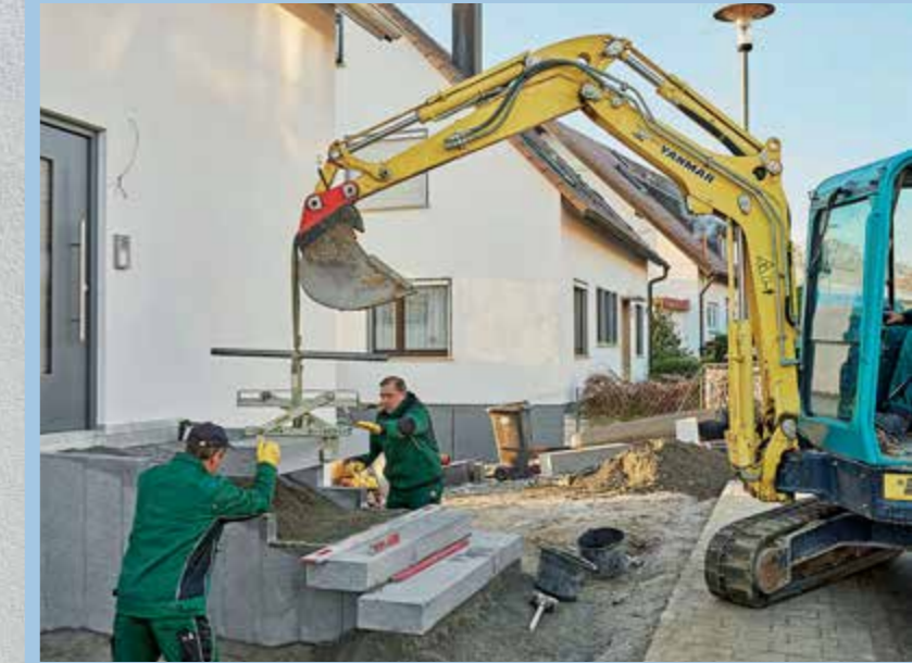
2. Bevor die ersten Stufen verlegt wurden, hat man den Zwischenraum verfüllt und gut verdichtet. So konnten die massiven Steintritten quasi vollflächig verlegt und vermörtelt werden.
