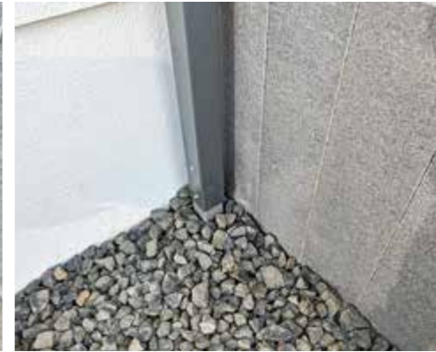
21. Damit der verzinkte Fuß nicht mehr zu sehen ist, hat man ihn hier mit einer Schotterlage zugedeckt. So bleibt nur das schlanke Vierkantrrohr sichtbar.
