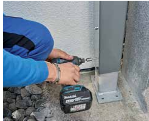
18. ... Stützenfuß von unten einfädeln kann und die Höhe mit zwei Schrauben fixiert. Nun kann der Pfosten zurechtgerückt und ausgerichtet werden.
