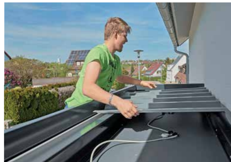
29. Als Regenwasser-Abführebene dienen Trapezbleche, die auf Maß vorgeschritten waren und nur noch eingelegt werden mussten. Mit ihrem leichten Gefälle ...
