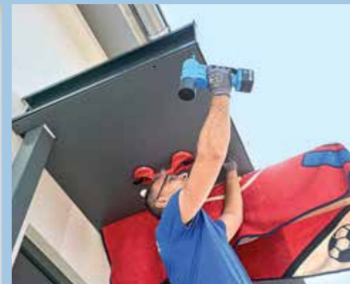
26. Denn auch diese Platte wird nun vor Ort ruckzuck angenietet. Damit bekommt man eine glatte Unterseite, die ebenso wie die Seitenblenden für eine ...
