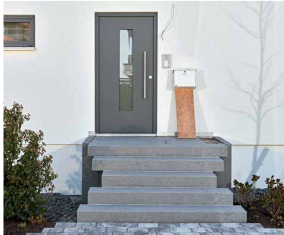
5. Das obere Podest wurde zwischen dem Rand des Stelen-Unterbaus und der oberen Stufe aufgefüllt und so hoch glattgezogen, dass der Plattenbelag bündig abschließen konnte. Rechts der Anschluss fürs Fallrohr.
