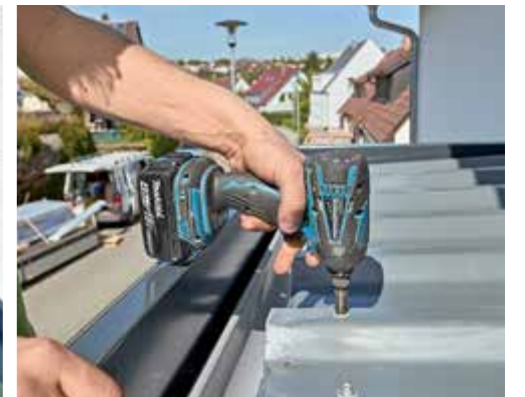
31. Damit die Bleche bei starkem Wind nicht weggehweht werden, setzt man sie mit selbstbohrenden sowie abdichtenden Schrauben vorne und hinten an der Metalltragkonstruktion fest.
