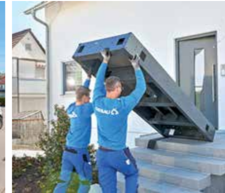
9. Mit zwei Mann war die Seitenwand schnell aufs Podest gebracht worden. Hier sieht man, wie sich das konstruktive Innenleben darstellt.
