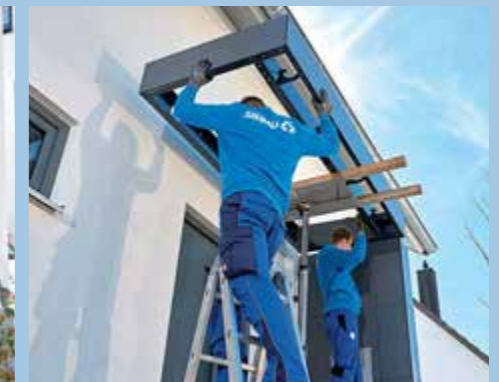
13. ... Bauteil langsam nach oben hievte, bis es auf der rechten Seite auf der Seitenwand aufgelegt werden konnte. Damit es dann vorerst ...
