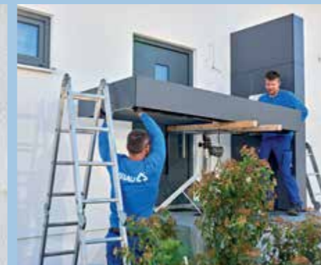
12. Denn jetzt folgte der Hauptakt – die Montage des Dachs. Hierzu bedienen sich die Monteure einer Liftanlage, die dann das quer aufgelegte ...
