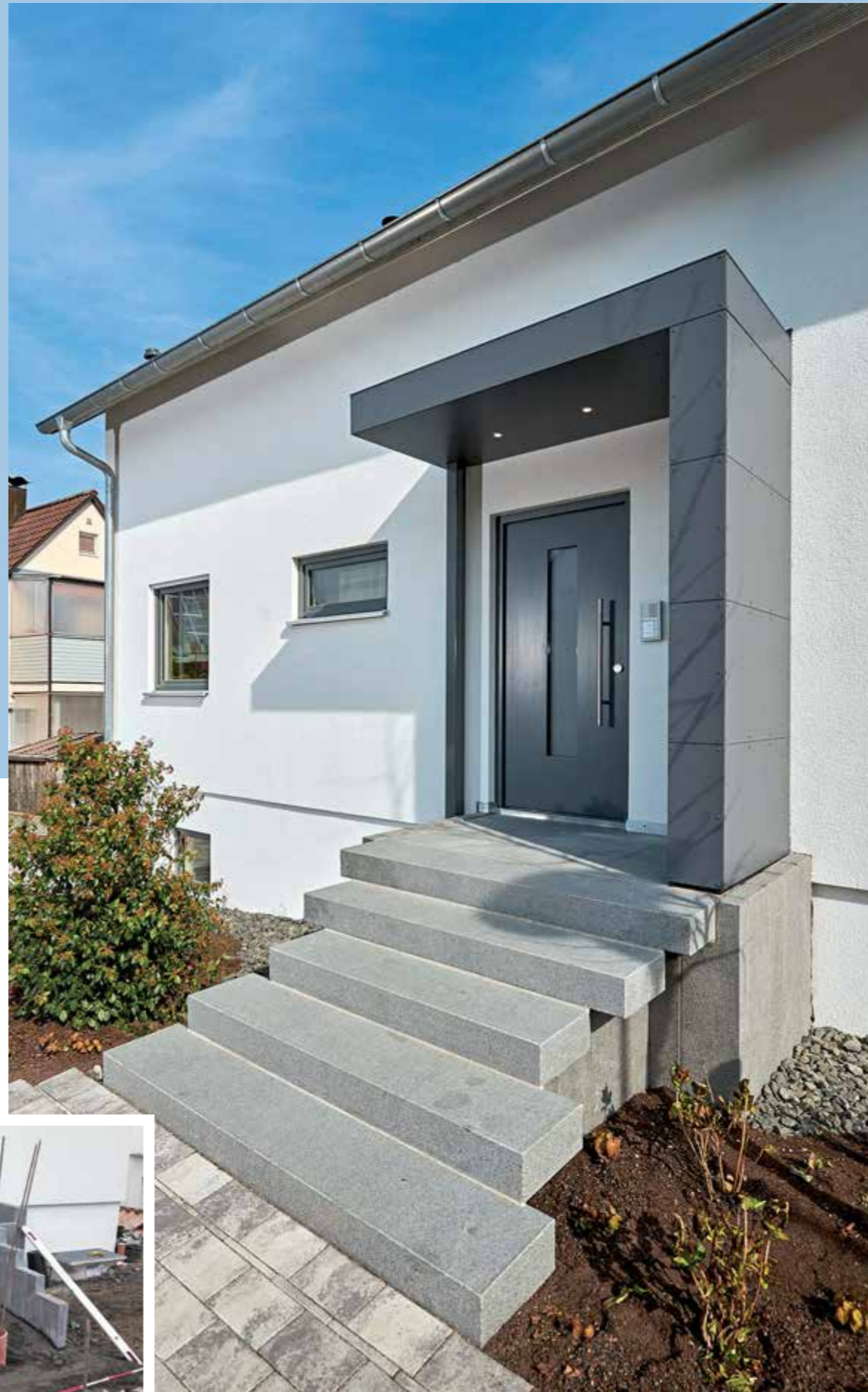
2. Bevor die ersten Stufen verlegt wurden, hat man den Zwischenraum verfüllt und gut verdichtet. So konnten die massiven Steintritten quasi vollflächig verlegt und vermörtelt werden.
