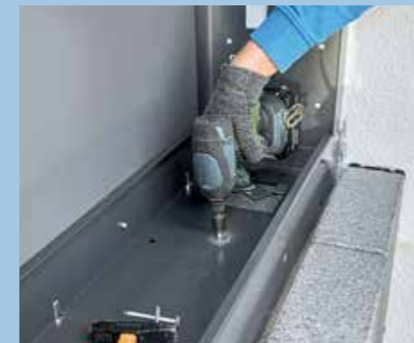
11. Zur vorläufigen Sicherung der Wand wurden an zwei Stellen Dübellöcher durch die Bohrungen im Blech erstellt und Schrauben eingedreht.
