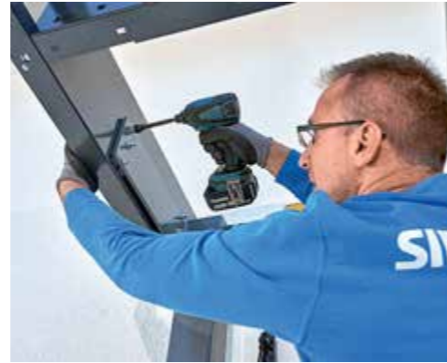
19. Dann erfolgt die endgültige Verschraubung an der Dachkonstruktion mit einem Schlagschrauber und Gewindeschrauben.
