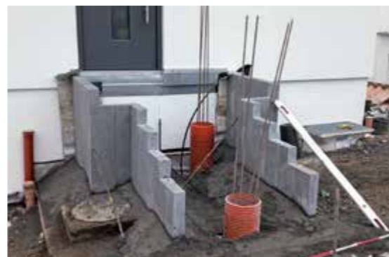
1. Der Unterbau für den Treppenaufgang besteht aus einbetonierten Stelen, die das Tritt- und Höhenmaß bereits berücksichtigen.
