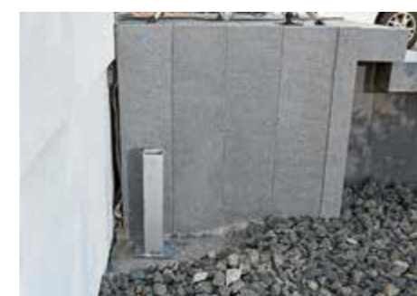
15. Für die sichere Abstützung des freien Dachbereichs wurde unten neben dem Podest auf einem Punktfundament ein Stützenfuß platziert.
