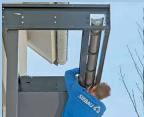
24. In die bereits vorhandenen Rinnenhaken lässt sich die PVC-Regenrinne nun mit entsprechendem vorgegebenem Gefälle leicht einclippen.
