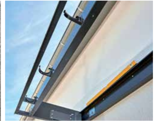
22. Jetzt geht es wieder oben weiter: Der Dachrahmen hängt nun frei vor der Fassade und es können nun die Entwässerungsbaueteile eingebaut werden.
