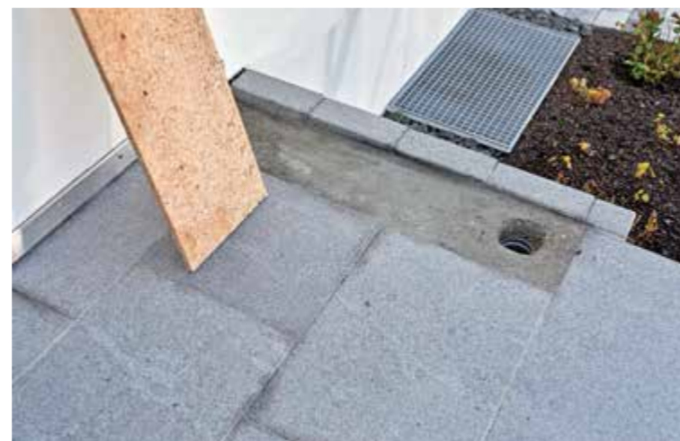
7. ... fand dann exakt Platz in dem noch freigebliebenen Bereich der Podestfläche. Hier erkennt man auch gut, dass der Flächenbelag mit Gefälle vom Haus weg verlegt ist, während der Streifen für die Vordachseitenwand waagrecht verläuft. Das erleichtert die Montage der Wand.
