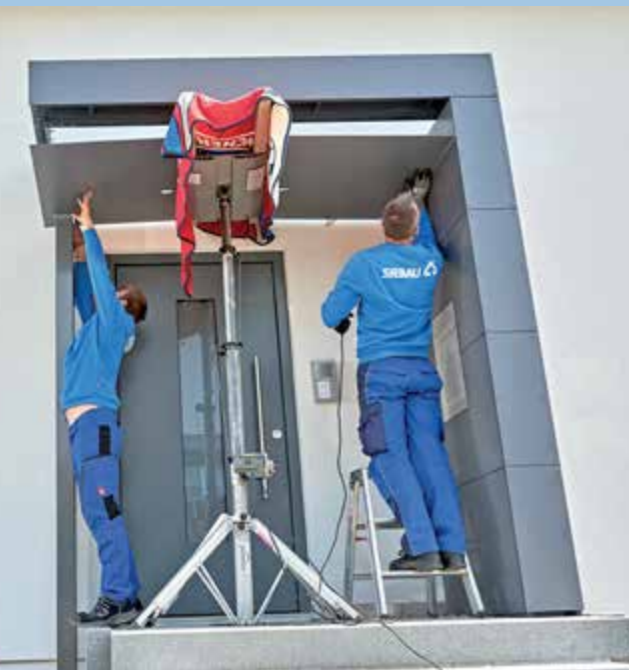
26. Denn auch diese Platte wird nun vor Ort ruckzuck angenietet. Damit bekommt man eine glatte Unterseite, die ebenso wie die Seitenblenden für eine ...
