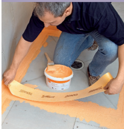
10. ... wird die Fläche mit Voranstrich behandelt und in den Anschlussbereichen das Abdichtungsband eingesetzt. Alle Fugenbereiche werden überarbeitet.
