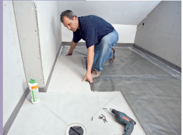
7. ... dem Zusammenschieben der Estrichplatten für eine verrutschfreie und dichte Verbindung. Die Falzausbildung ihrerseits garantiert eine versatzfreie Oberfläche des dann zum Verfliesen fertigen Bodens.
