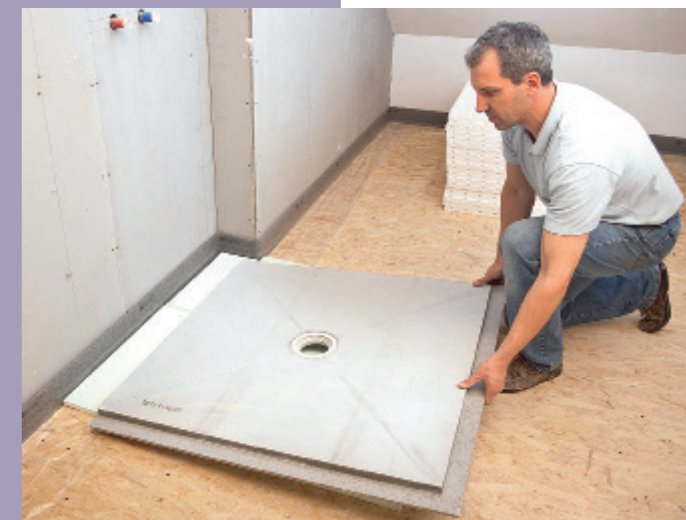
4. Dann folgte das Setzen des Duschelements am in die Decke integrierten Ablauf. Würde der Ablauf oberhalb des Rohbodens liegen, wäre ein Niveaugleich der gesamten Fläche mit gebundener Schüttung erforderlich.
