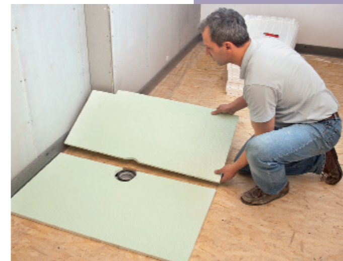
3. Wichtigstes Element im neuen Dachbad ist die Dusche. Hier hat man sich für einen verfliesen Duschboden entschieden. Dafür wurde zunächst eine Hartschaum-Dämmunterlage mit Ausschnitt für den Bodenablauf verlegt.
