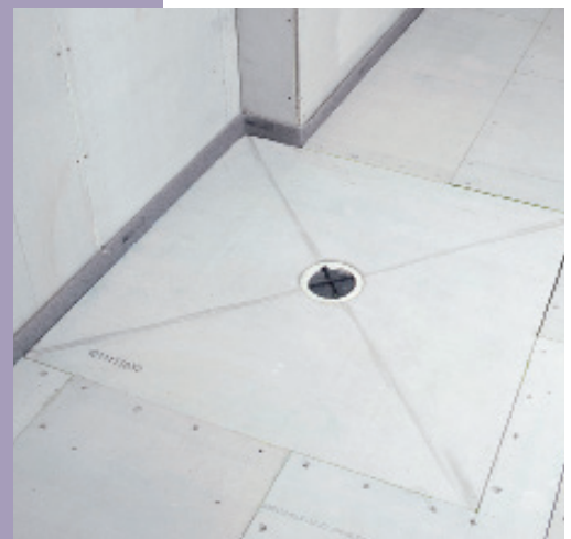
9. Und so sieht der Duschbereich im Rohzustand aus: Ein bodengleicher Ablauf und eine barrierefreie Fläche sind entstanden. Bevor dann beides verfliest wird, ...
