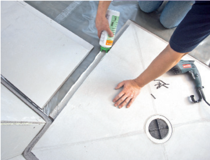
6. Direkt daran anschließend wird der restliche Badraumboden verlegt. Im Falzbereich der Estrich-Elemente sowie des Duschelements wird der emissionsfreie greenline Estrich-Kleber aufgetragen. Die Verklebung sorgt nach ...
