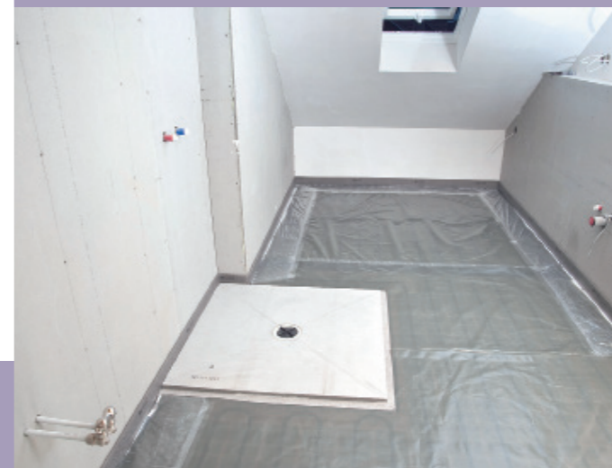
5. Zwischen dem Untergrund und den dann folgenden Trockenestrich-Elementen wurde noch eine Fußbodenheizung integriert. Sie bleibt unterhalb des Niveaus des Duschelements und wird mit Folien abgedeckt.
