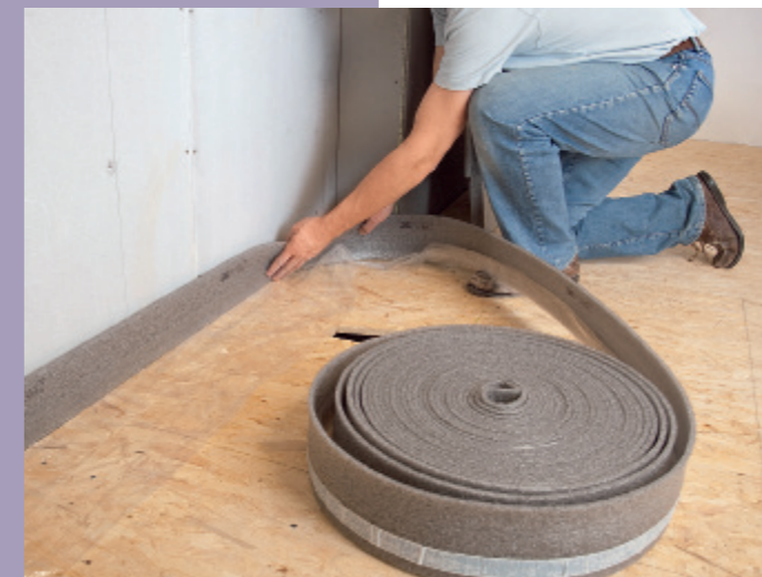
2. Zur Vermeidung von Schallbrücken sind im Raum rundum Randdämmstreifen einzubauen. Sie haften an der Wand. Auf dem Rohboden (hier eine neue stabilisierende OSB-Plattenlage) legt man den Folienstreifen aus.
