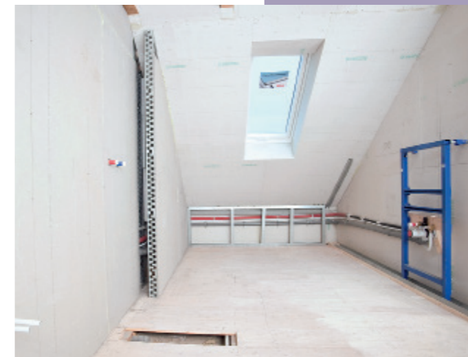
1. Der nachträgliche Badausbau wurde komplett mit Trockenbauplatten ausgeführt. Dachschräge und Fenster sind fertig, die neuen Versorgungsleitungen sind geführt und verschwinden dann hinter der Plattenbeplankung.
