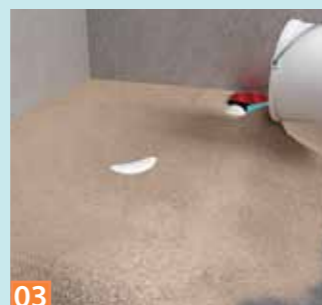
03 Nun wird die Schüttung angemischt und bis Oberkante Ablauftopf ausgebracht und nivelliert. Dann lässt man sie trocknen.
