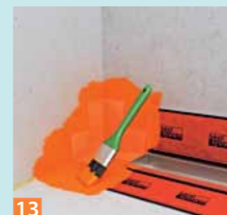
13 Die Flächen werden vorab grundiert, dann werden zu den angrenzenden Bauteilen Dichtecken mit Flüssigfolie eingeklebt.
