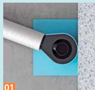
01 Der Ablauftopf wird mit schalldämmendem Schaumstoff umhüllt und mittig im Gefällebereich an der Wand positioniert.
