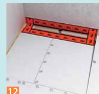
08 Nun muss zunächst der Randdämmstreifen bündig abgeschnitten werden, dann entfernt man den Schutzkleber vom Ablauf.
