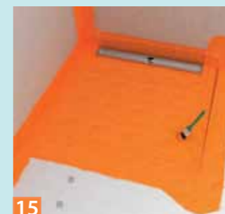
15 Dann wird der ganze Gefällebereich vollflächig abgedichtet. Nach dem Trocknen des ersten Auftrags folgt noch ein zweiter.
