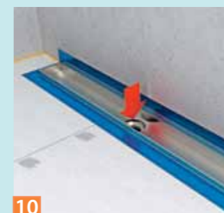
06 ... fügt man das zweite Element hinzu und verschraubt die Teile im Überlappungsbereich im Abstand von ungefähr 15 cm.
