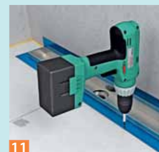
07 Darum herum 30-mm-Hartschaumplatten und Powerpanel TE-Elemente verlegen, Kleber abstoßen, Schrauben verspachteln.
