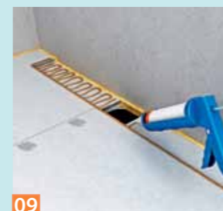
05 Jetzt werden zunächst zwei Klebeschnüre Estrich-Kleber mit etwa 5 mm Durchmesser auf den Stufenfalz aufgetragen, dann ...
