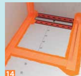
14 Danach klebt man Fermacell Dichtbänder mit Flüssigfolie umlaufend auf die Stöße des Gefälleelementes.
