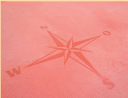
7. Nach dem Entfernen der Designfolie wurde die Fläche mit Cryl Finish versiegelt. Das Ergebnis ist eine optisch ansprechende, dauerhaft ...
