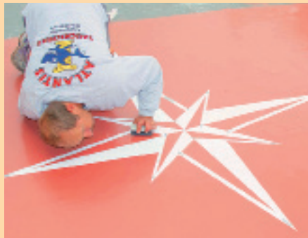
5. Die Folientechnik ist eine Ergänzung zu den Abdichtungssystemen und wertet Flächen mit individuellen Akzenten auf.
