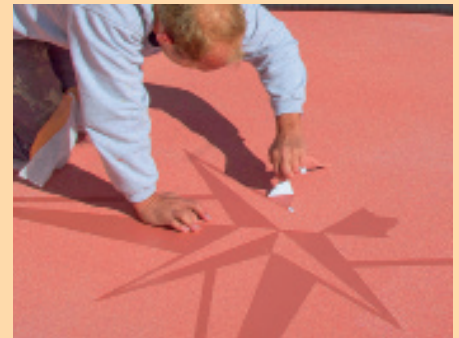
6. Die Motivfolie wird auf die erste Versiegelung aufgebracht, farblich ausgeprägt und wieder entfernt. So wird das gewünschte Motiv sichtbar.
