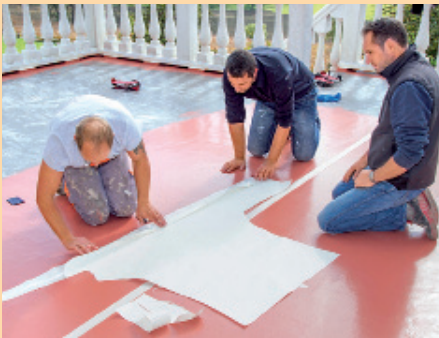
4. Zur Darstellung einer Windrose kam Creative Design zum Einsatz. Es wird auf die zuvor mit ProFloor hergestellte Nutzschrift aufgebracht.
