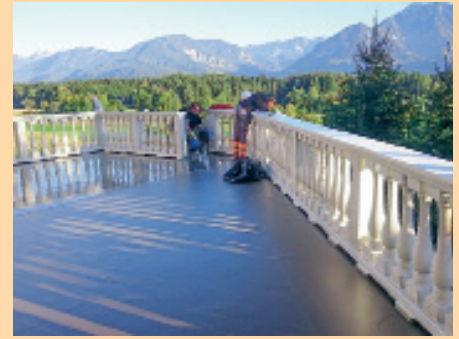
3. Mit der vliesarmierten Systemkomponente Triflex ProTerra haben sie das 70 Quadratmeter große Areal in der Fläche abgedichtet.
