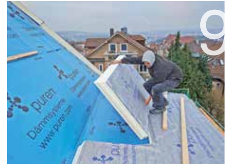
Die Dämmelemente mit umlaufender Nut-Feder-Verbindung bilden über den Sparren einen vollflächigen Dämmmantel.
