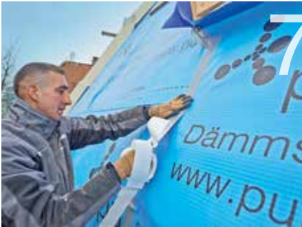
Zur Abdichtung der Querstöße gibt es im System ein sehr leistungsfähiges Klebeband, das gut und dauerhaft dichthält.
