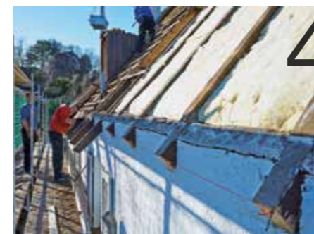
4 Die abgesägten Sparrenköpfe erlauben eine einfache Führung der Luftdichtheitsebene hinunter bis auf die Außenwand.
