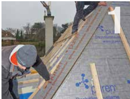
Auch die Grate unseres Walmdachhauses sind so oberhalb der Dämmebene winddicht und wasserführend verklebt.
