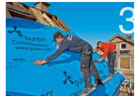
3 An den jeweiligen Überlappungsbereichen kommt es dann auf die sorgfältige Verklebung der Folien untereinander an.
