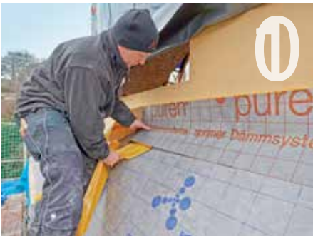
Mit dem selbstklebenden First- und Gratband wird die Dämmfläche sicher an den aufgehenden Bauteilen angeschlossen.
