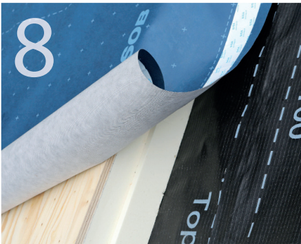
Schichtenaufbau (von oben): Luftdichtheitsebene (blau), Aufsparrendämmelement ThermoSkient D und Vordeckung/Dampfbremse.
