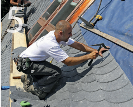
Die Befestigung der nachfolgende Eindeckung aus Schieferplatten erfolgt dann direkt in der Holzwerkstoffplatte. Die aufgerauten...
