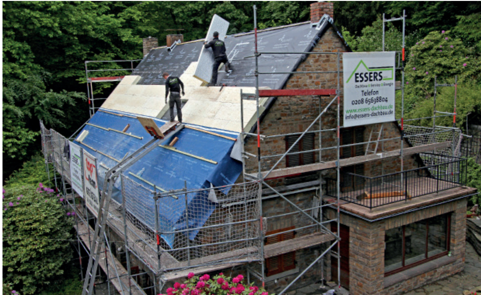
Zu schade, um die Original-Fassade einfach wegzudämmen: Um dennoch gute Dämmwerte fürs Gebäude insgesamt zu erzielen, hat man den Fokus hier auf die Dachdämmung gesetzt.
