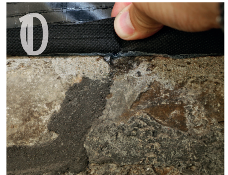
Eine 4 mm dicke Kleberaube sichert die solide Verklebung der Luftdichtheitsebene auf der ebenen Oberfläche des Bruchsteinmauerwerks.
