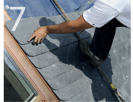
Die Einbindung von Blechen an aufgehenden Bauteilen oder wie hier der Fenster-Eindeckrahmen ist Sache erfahrener Schieferdecker.
