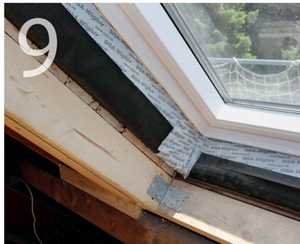
Ganz wichtig fürs energieeffiziente Dämmdach: Die sorgfältige Verklebung der Luftdichtheitsebene mit dem Dachfensterrahmen.
