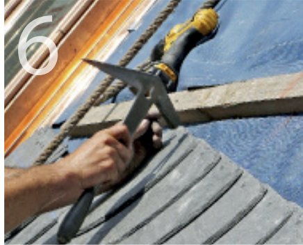
...Edelstahlnägeln lassen sich leicht einschlagen. Die schuppenartig überlappenden Schieferplatten decken die Nagelstellen exakt ab.
