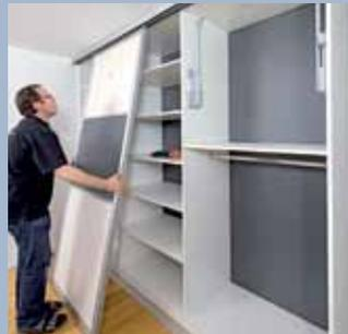
**6.** Nun die erste Tür einhängen. Es ist alles vormontiert, so dass keine weiteren Detailarbeiten anfallen.
