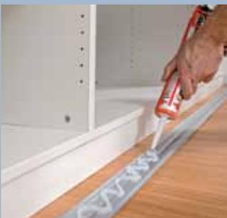
**11.** Denn sie muss ja verklebt werden. Dazu Silikon oder Montagekleber auf die Rückseite auftragen.
