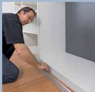
**12.** Mit Hilfe der Markierung findet man dann den richtigen Verlauf der Schiene und drückt diese an.
