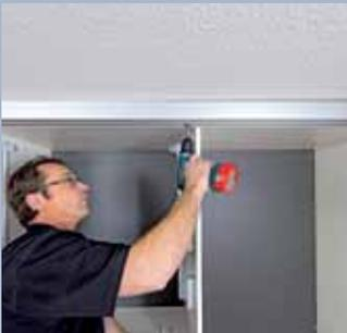
**5.** Nun werden an allen Fixierpunkten die Schrauben festgezogen. Die Schiene ist montiert.
