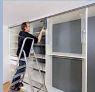
**3.** Am besten ist es, erst einmal in der Mitte eine Deckenbohrung durchzuführen und zu fixieren.
