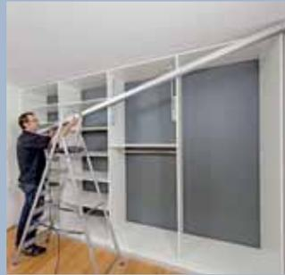
**2.** ... Alu-Deckenschiene montiert. Deren Montage erfolgt also unabhängig von den Korpusen.
