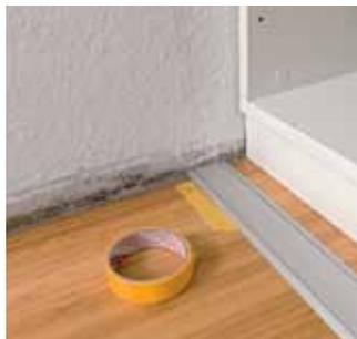
**10.** Dann mit Klebeband die Position der Schiene markieren, bevor sie wieder weggenommen wird.
