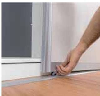
**15.** Die Rollen genau platzieren und den Türenlauf fein justieren, sodass alles reibungslos läuft.
