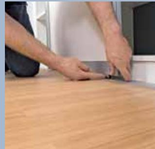
**7.** Auf die zuvor lose verlegte Bodenschiene wird nun die Tür bzw. werden die Laufrollen aufgesetzt.
