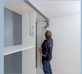
**4.** Dann lässt sich an den weiteren Stellen die Schiene einfacher durchbohren und befestigen.
