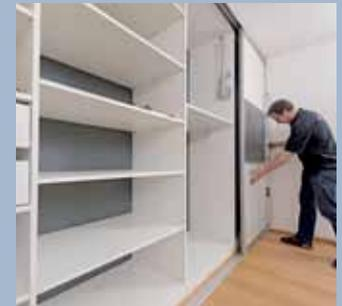
**8.** Diese Tür dann einmal probeweise verschieben, um den Sitz der Bodenschiene zu optimieren.
