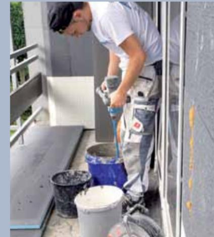
4. Das frostsichere Material für die Hartschaumplattenverklebung wird klumpenfrei verrührt ...
