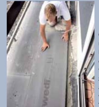
6. ... nach innen verklebt. Diese 3 cm dicken Platten dienen zum Höhenausgleich wegen der Türschwelle.
