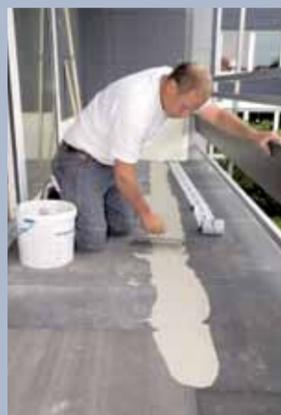
11. Das Dichtset wird zur Fugenabdichtung eingesetzt. Erst wird die 2 K-Dichtschlämme aufgetragen, ...
