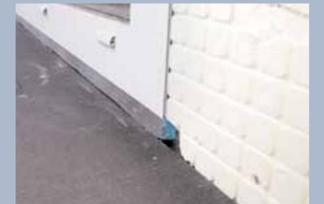
10. Gut zu sehen, wie die Balkonbodendämmplatten an die neue Fassadendämmung und am Balkontüranschluss angearbeitet wurden.
