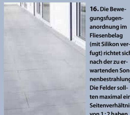
16. Die Bewegungsfugenanordnung im Fliesenbelag (mit Silikon verfugt) richtet sich nach der zu erwartenden Sonnenbestrahlung. Die Felder sollten maximal ein Seitenverhältnis von 1:2 haben.
