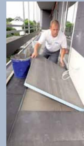
9. Die Gefälleplatten sind stoßversetzt – auch zur unteren Lage! – zu verlegen, um noch mehr Stabilität zu bewirken.
