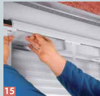
11 Jetzt steckt man erst die Motorseite des Bauteils in das Motorlager und führt dabei das Kabel des Motors nach unten weg. Dann ...
