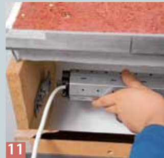
07 An der gekennzeichneten Stelle wird das Motorlager des Rohrmotors an der Stirnseite des Rolladenkastens angeschraubt.
