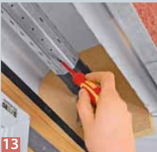
09 Nun wird zunächst die neue Walzenkapsel in die Achtkantstahlwelle eingeführt. Die Führungsnut sorgt für Formschluss.
