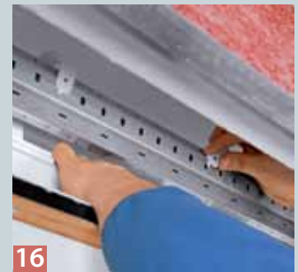
12 ... steckt man die andere Seite mit der Walzenkapsel ins Gegenlager, zieht dabei die Kapsel so aus der Welle, dass es passt.
