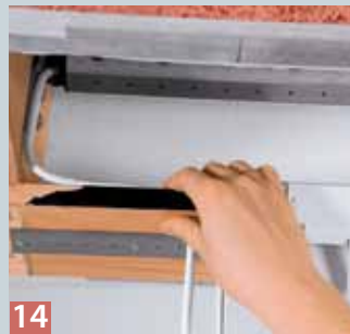
10 Danach schiebt man den Rohrmotor sanft in die Achtkantstahlwelle. Der Laufringadapter muss dabei aufgesteckt sein.
