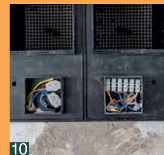
06 Vom Gerät ausgehend werden die Kabel eingezogen und am besten mit Blitzgips fixiert. Links liegt das Kabel zur Steuerung.
