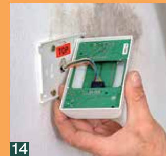
10 Die Anschlüsse des Gerätes nach Anleitung mit Lüsterklemmen verbinden. Dann die Boxen mit den Abdeckungen schließen.
