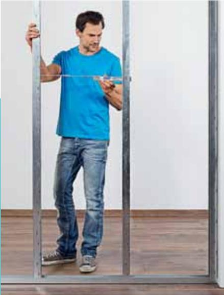
**1.** Die horizontalen Profile unter Verwendung von Dämmstreifen mit Boden und Wand verschrauben, dann im Abstand von 58 cm die senkrechten Profile einsetzen.
