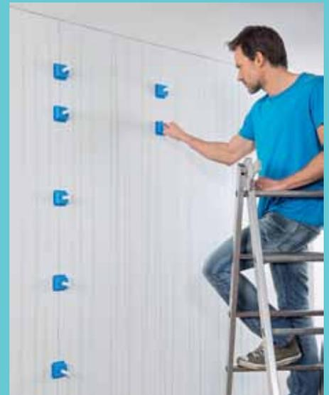
**6.** Ist eine Wandseite fertig, können Mineralwolleplatten eingesetzt werden. Schließlich nach Trocknung des Klebers an den Zips ziehen, bis sie abreißen.
