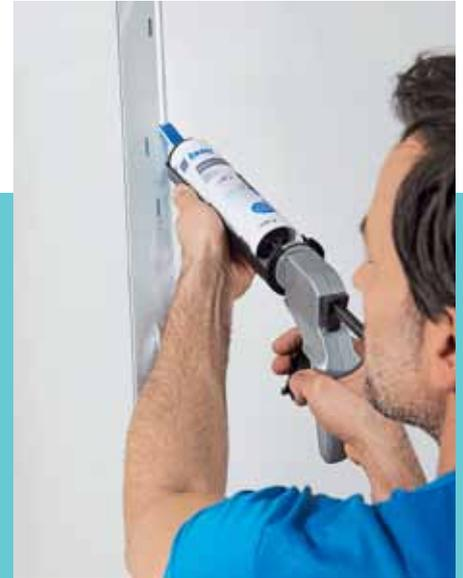
**3.** Die Spezialtülle der Kleberkartusche an der inneren Profilkante ansetzen und den Kleber gleichmäßig und umlaufend auf die Profile auftragen.
