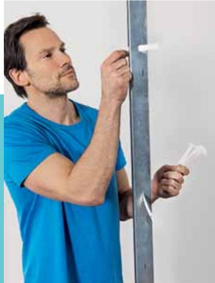
**2.** Die Zips von hinten nach vorn durch die mittleren Schlitz der CW-Profile führen – ganz unten, ganz oben und dazwischen immer in gleichmäßigen Abständen.
