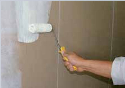
1. Vor der Verklebung ist ein Grundieren der glatten Tragwand empfohlen.
