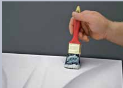
4. Der Kleberauftrag erfolgt auf den Platten- rückseiten auf den späteren Kontaktflächen.
