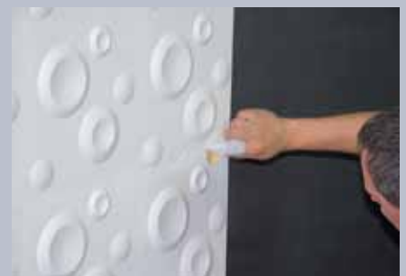
8. ... nach dem Aushärten mit einem feinen Schleifpapier glätten bzw. beischleifen.
