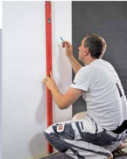
2. Mit einem Linienraster bzw. einer ersten Hilfslinie kann man die Wand besser aufteilen und sorgt so für senkrechten Sitz der Platten.
