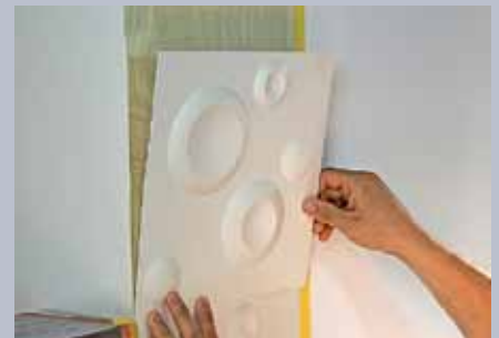
5. Platte an Platte dann möglichst fluchtgerecht und direkt ansetzen und leicht andrücken.
