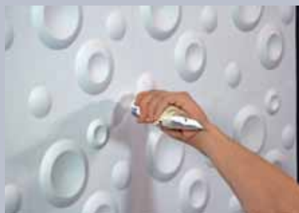
7. Die leichten Fugen lassen sich mit einer Naht- paste überarbeiten. Diese auftragen und ...
