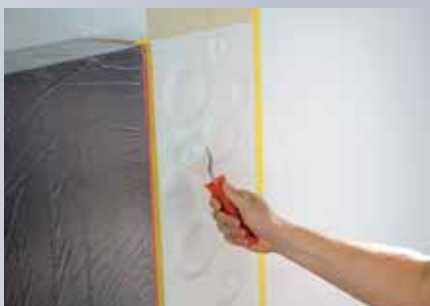
6. Mit einem Nahtroller kann man dann noch die Kontaktflächen gezielt andrücken.
