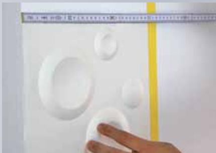
3. Die 30 x 30 cm messenden Elemente orien- tieren sich hier an einem aufgeklebten Streifen.
