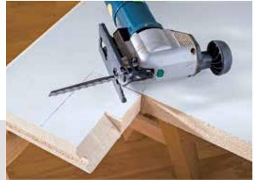
**4. Die Innenausbauplatten** können mit handelsüblichen Holzbearbeitungsmaschinen leicht zugeschnitten werden.
