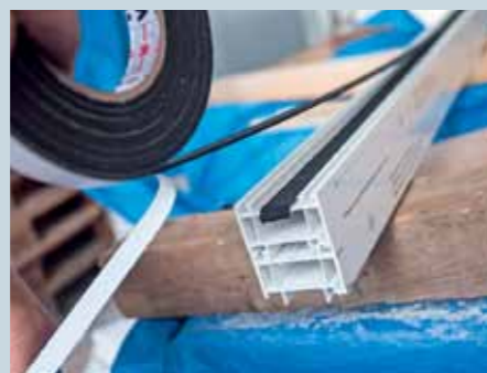
2. Der thermisch getrennte Bodeneinstand wird mit einem Abdichtband zur Montage vorbereitet.
