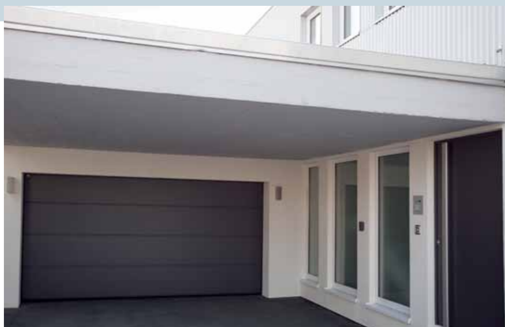
14. Harmonie auch an der Fassade: Neue Haustür, Aufteilung der Fensterbänder und das Design des ebenfalls neuen Garagentors sind sensibel aufeinander abgestimmt.
