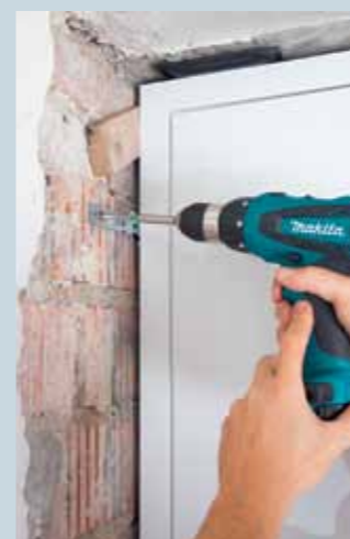
11. Anschließend erfolgt die Befestigung der Zarge am Mauerwerk mit Hilfe von Montagelaschen.
