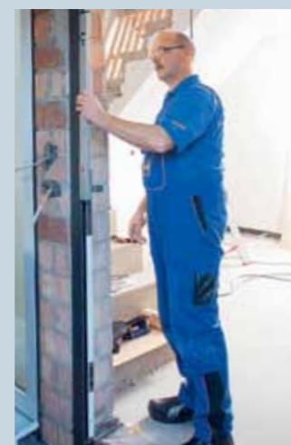
9. Der senkrechte Sitz zwischen den neu gemauerten Pfeilern wird mit der Wasserwaage überprüft.
