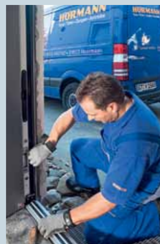
8. Dann folgt das exakte Ausrichten des Bauelements. Die Zarge soll ja parallel zur Laibung sitzen.
