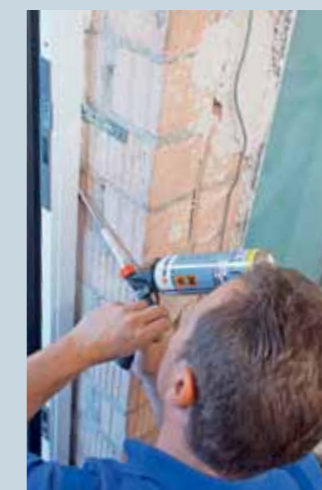
13. Der dann eingebrachte Montage-schaum ist die dritte Dichtungsebene in der Bauanschlussfuge.
