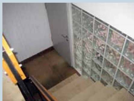
1. Diese einfache Tür sollte einer modern design-ten und energetisch optimalen Haustür weichen.
