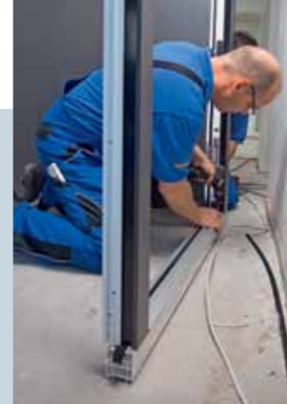
4. ... und montieren den Bodeneinstand unter die thermisch getrennte Schwelle.
