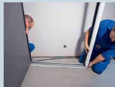
3. Die Monteure stellen die Eingangstür auf, nehmen die Transportsicherungsschiene ab ...
