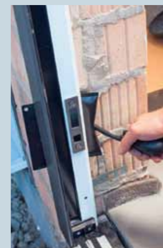
10. Sogenannte Winbags (aufblasbarer Luftbeutel) helfen zusätzlich beim Ausrichten der Türzarge.
