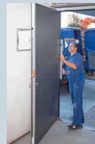
12. Sichtprüfung der Spalt- und Fugenmaße und nochmalige Kontrolle des einwandfreien Sitzes.
