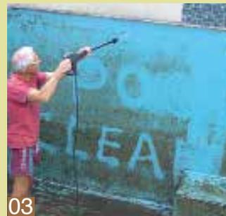
**03** Der Dreckfräsersvorsatz ist dann das richtige Werkzeug, um die Poolwände effektiv und lückenlos abzuspritzen, auch bei Folie.
