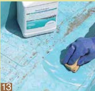
**13** Mit einem angefeuchteten Vlieschwamm bearbeitet man den abgelösten Kalk und entfernt ihn so von der Folie. Am Boden kann ...
