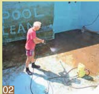
**02** Mit Hilfe eines Hochdruckreinigers arbeitet man sich bis zur tiefsten Bodenstelle vor und kann so das Material zusammentreiben.
