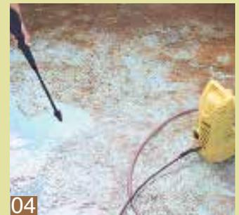
**04** Hartnäckige Ablagerungen werden ebenfalls mit der Dreckfräse (Rotationsstrahl) bearbeitet. Das muss konsequent geschehen.
