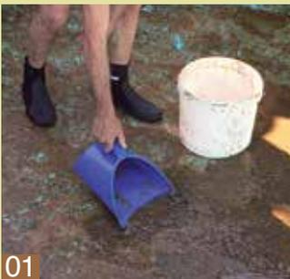
**01** Nach dem Abpumpen des Poolwassers muss zunächst das grobe Mulmmaterial abgeschöpft und komplett ausgeräumt werden.
