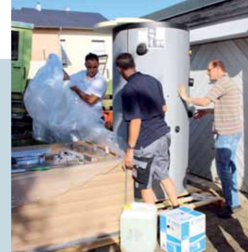
1. Das für die Montage der Kollektoren abgestellte Montageteam des Herstellers inspiziert zusammen mit dem Heizungsbauer die Lieferung.
