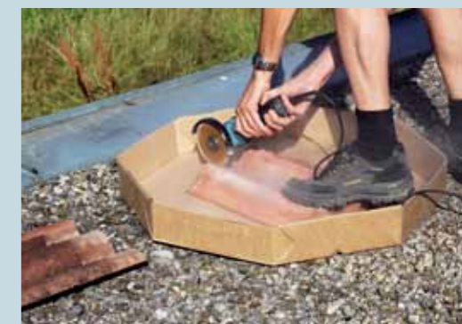
6. Damit die Dachsteine nicht abstehen, wenn sie auf den montierten Haken eingegliedert werden, schneidet sie der Monteur per Winkelschleifer zu.
