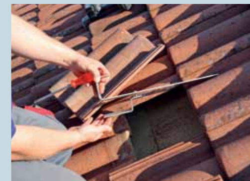
3. Der Dachhaken hat eine spezielle Klemmkonstruktion. Auf ihm wird später die Montageschiene zur Befestigung der Kollektoren verschraubt.
