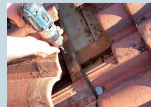
2. Damit die Kollektoren auf dem Dach sicher halten, werden die Dachlatten an den relevanten Stellen zusätzlich mit den Sparren verschraubt.
