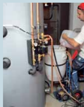
29. Der Solarkreislauf wird mit hochtemperaturbeständigem Frostschutz befüllt.
