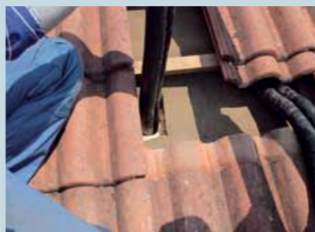
17. Die gedämmte zweirohrige (Vor- und Rücklauf) Solarleitung wird im Bereich des Dachüberstandes durch eine Öffnung nach unten geführt.
