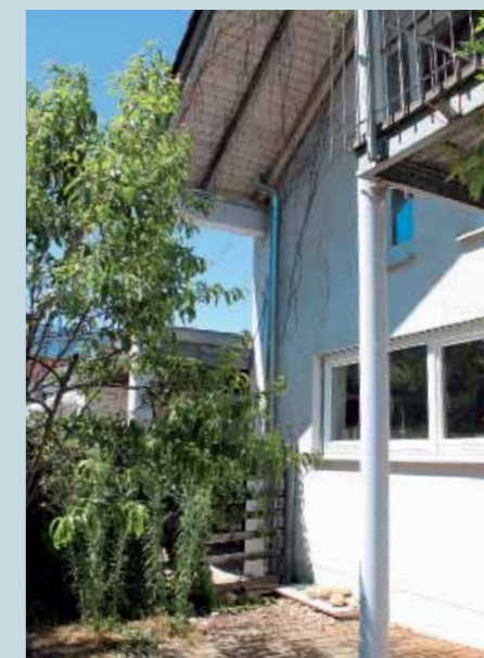
21. Das Fallrohr wird mit Mauerschellen gesichert, dann deutet nichts mehr auf das Vorhandensein einer Solarleitung hin.
