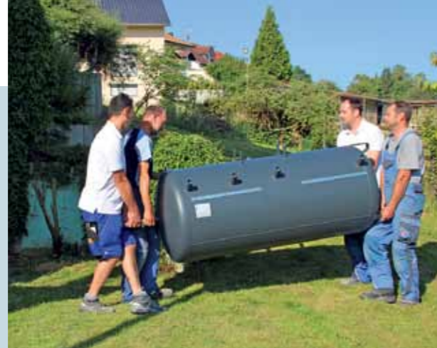
23. ... die zum Systemspeicher führen, an. Ohne Dämmung hat der Speicher einen Durchmesser von 790 mm und passt so gut durch die Türen.
