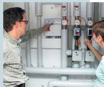
30. Schließlich erhalten die Eigentümer noch eine kompetente Einweisung am Schichtladeregler.
