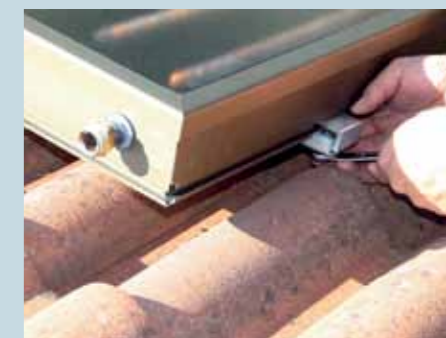
11. Mit Hilfe stabiler Endklammern aus Aluminium werden die Kollektoren zusätzlich auf der Lochschiene gesichert.
