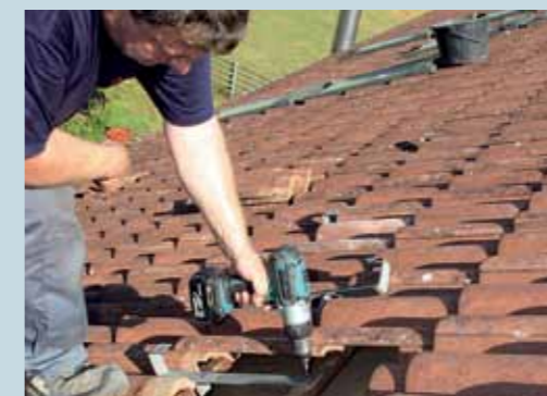
5. ... anschließend wird das obere Ende des Dachhakens mit Hilfe eines Akkuschraubers fest mit den Dachlatten verschraubt.
