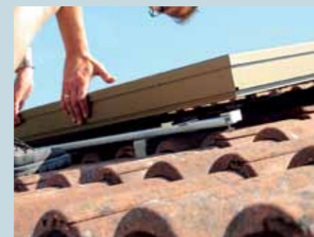
10. Das auf der Unterseite des Kollektors eingearbeitete Montagehängeprofil dient als Montagehilfe, damit der Kollektor gleich richtig sitzt.
