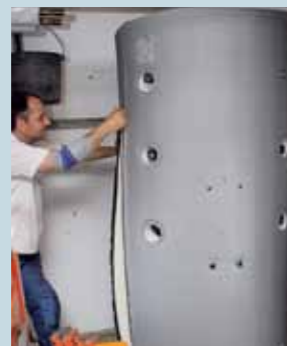
25. Dann wird der Speicher mit dem Dämmmantel eingepackt. Die größten ...
