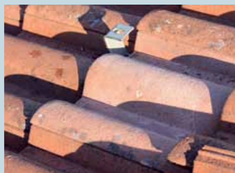
7. Ein fertig montierter Dachhaken mit eingesetztem Dachstein. Die Dachhaut ist wieder vollständig intakt und regensicher.
