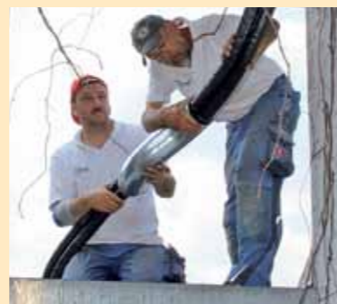
18. Vom Dachauslass bis zum Sockel des Hauses verläuft die Solarleitung gut geschützt und getarnt senkrecht nach unten.
