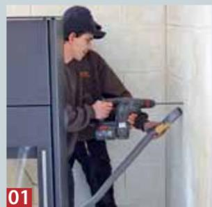
**01** Die Lage des Mittelpunktes der Rohrdurchführung durch die Wand nach außen wird ermittelt. Dann wird das Loch für die ...
