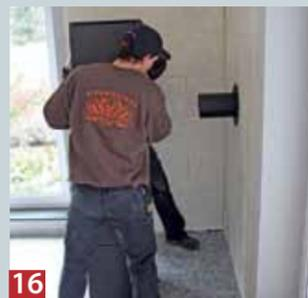
**16** ... Kaminofen herangerückt, mit dem Rohrstück verbunden und so an den Edelstahlschornstein angeschlossen.
