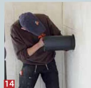
**14** Anschließend wird von innen der Rohranschluss des Kaminofens in das Wandstück des Schornsteins geschoben und ...
