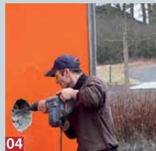
**04** Anschließend wird der Wanddurchbruch mit einem Bohr- und Meißelhammer Schritt für Schritt ausgestemmt.
