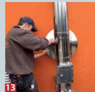
**13** Rund um das waagerechte Rohr, schon beim Einbau unterfüttert, wird Steinwolle gestopft, dann eine Rosette angebracht.
