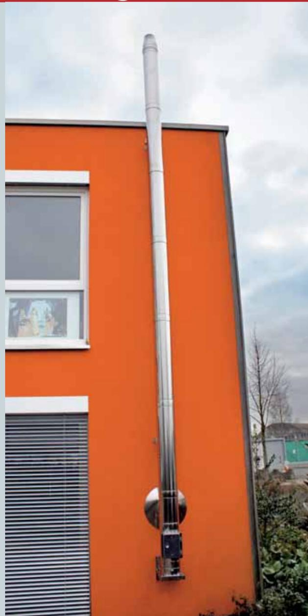
Mit professioneller Planung und hochwertigen Produkten kann die Montage eines Edelstahlschornsteins auch in Eigenleistung durchgeführt werden. Etwa mit einer Konsole an der Außenwand.
