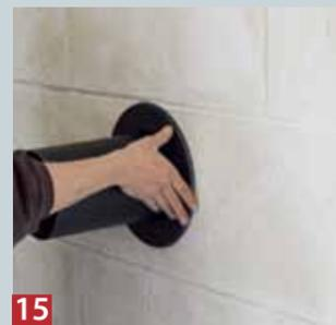
**15** ... die Fuge zwischen Rohr und Außenmauer mit einer Wandrosette abgedeckt. Zum Abschluss wird der ...
