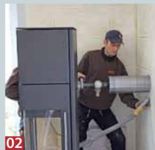
**02** ... Aufnahme des Zentrierbohrers des Kernbohrers erstellt und dann die Hauptbohrung angefertigt.
