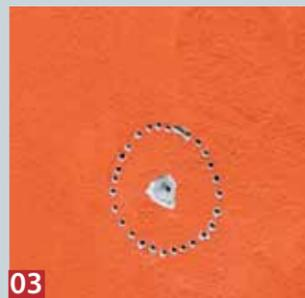
**03** Ohne den Einatz eine Kernbohrgerätes bohrt man von innen durch, zeichnet den Radius an und bohrt außen vielfach vor.
