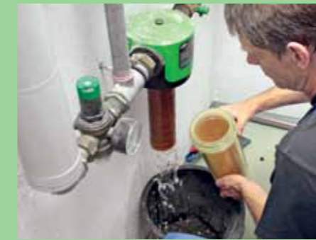
1. Demontage des alten, nicht rückspülbaren Trinkwasserfilters. Mit wenigen Handgriffen ...
