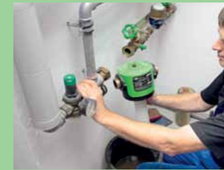
2. ... ist der Filter aus dem Leitungsstrang nach der Wasseruhr ausgebaut. An dessen Stelle tritt ...
