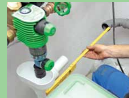
7. ... bis zum Filter verlegt, von wo aus das Spülwasser über den Trichter abgeleitet wird.
