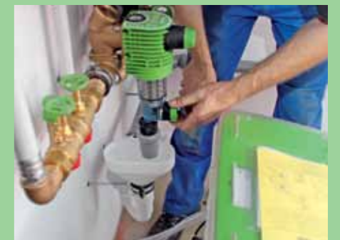
9. Beim Öffnen setzt der Rückspülbetrieb ein und leitet das Wasser in die Kanalisationsleitung ab.
