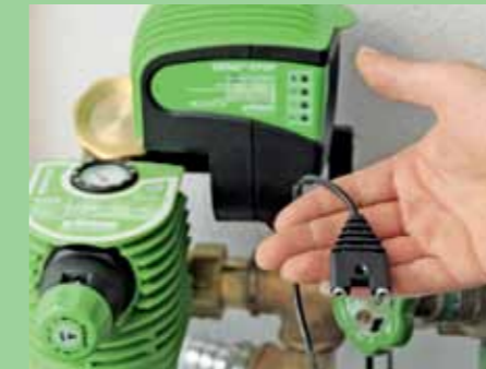
5. Ein Bodensensor sperrt bei unkontrolliertem Wasseraustritt im Raum sofort die Wasserzufuhr.
