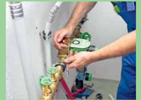
3. ... ein Filter mit unterbrechungsfreier Rückspülfunktion, Druckminderer und Manometer.
