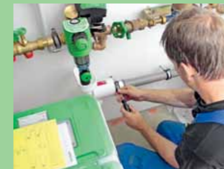
8. Das im Gefälle liegende Rohrstück wird nun dicht mit dem Anschlussflansch verbunden.
