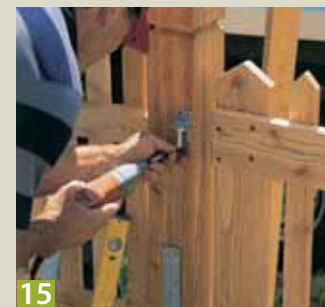
11 ... setzt man die erste Spitzlatte im vorher errechneten Abstand zum Pfosten fest und richtet sie in der Höhe an der Schnur aus.
