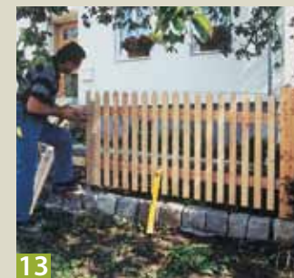
09 In gleicher Höhe werden an den Metallpfosten Formlaschen angebracht. Nun werden die Zaunriegel von hinten her befestigt.
