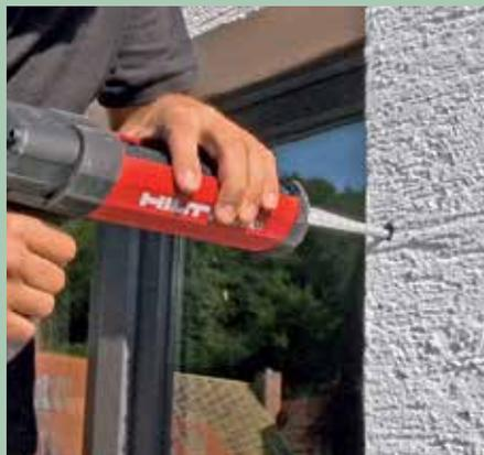
17. Dann Kloben mit Klebeband an den Ladenbändern mit dem Gewinde Richtung Hauswand befestigen (erleichtert die Montage) und Bohrlöcher mit Klebemörtel verfüllen.
