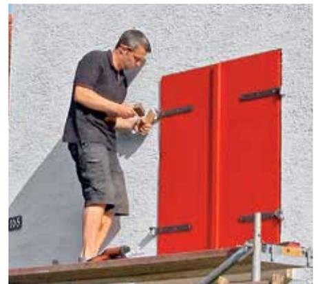
18. Klappladen einsetzen, fixieren und Klebeband von den Kloben entfernen. Fixieren bis der Klebemörtel ausgehärtet ist. Jetzt noch Verriegelungsbeschläge montieren und fertig.
