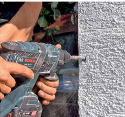
16. Zur Montage den Klappladen in der Fensteröffnung festkeilen, Bohrlöcher auf der Hauswand anzeichnen, Klappladen zur Seite stellen, bohren, Bohrstaub aus den Löchern entfernen.
