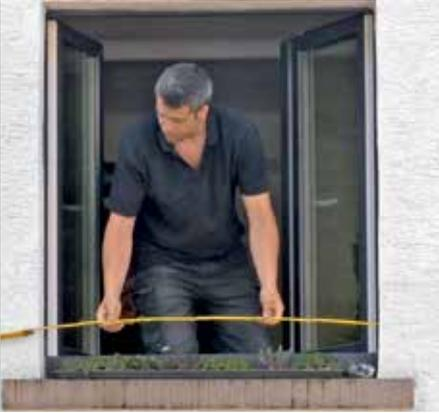
2. Um den Klappladen passgenau zu fertigen, werden zunächst die Fenster ausgemessen: einmal die lichte Weite (Abstand zwischen Fensterlaibungen) und die Höhe zwischen Fensterbrett und Sturz. Hierbei gilt es auf Genauigkeit zu achten, denn Messfehler lassen sich später nur noch schwer korrigieren.
