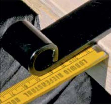
10. An der Klappladen-Außenkante die Mitte der Querfriese anzeichnen, mit einem Winkel auf der Außenseite des Klappladens mittig die Länge des Ladenbandes markieren, Bohrlöcher anzeichnen. Das Ladenband sollte 5,5 cm über die Außenkante überstehen (abhängig von Materialstärke und  $\phi$  der Ladenbandrolle).
