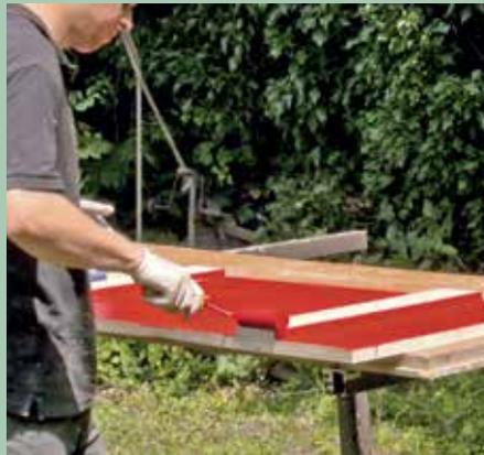
14. Klapppläden z.B. mit 2-in-1 Holzschutzfarbe beschichten. Dabei Verarbeitungshinweise des Herstellers beachten. Wenn die Beschichtung ausreichend getrocknet ist, Beschläge endgültig montieren. Dazu Schlossschrauben einstecken und von der Unterseite mit Unterlegscheibe und Mutter mit Knarre festziehen.
