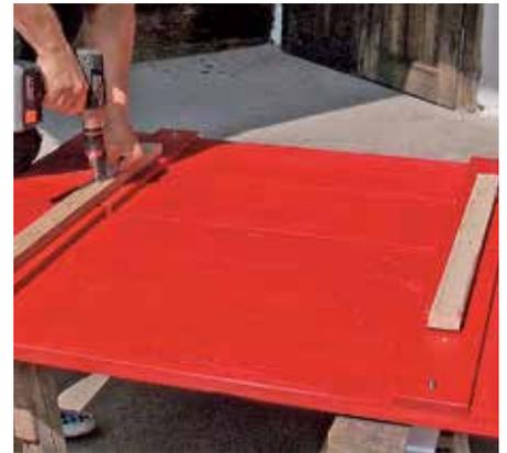
15. Der Klapppladen lässt sich leichter montieren, wenn beide Elemente miteinander verbunden sind. Hierzu eine Montagehilfe aus Dachlatten mit kleinen Schrauben auf die Querfriese schrauben und dadurch beide Läden miteinander verbinden.
