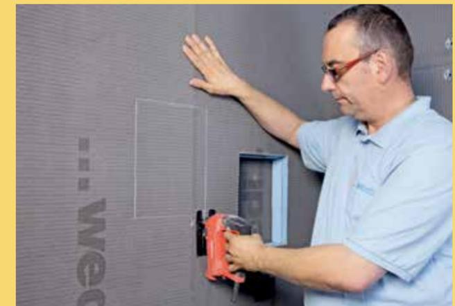
4. Aussparungen – wie hier die Nischen in der Dusche – werden einfach mit einer Stichsäge ausgeschnitten. Bauwünsche, die spontan entstanden sind, können somit – bis zum Zeitpunkt der Verfliesung – auch nachträglich umgesetzt werden.
