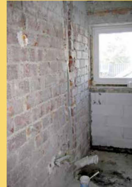
2. Die erfolgte Kernsanierung legte das Mauerwerk frei und zeigte, dass die Wände vor der Befliesung noch deutlich begradigt werden mussten.
