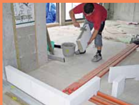
1. Vor dem Nassestrich-Einbau wird zur Abgrenzung ein Sockel aus Porenbeton angelegt.
