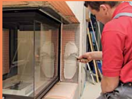
24. Das Gewebe wird auch auf den Laibungsflächen des Glasbereichs eingearbeitet.
