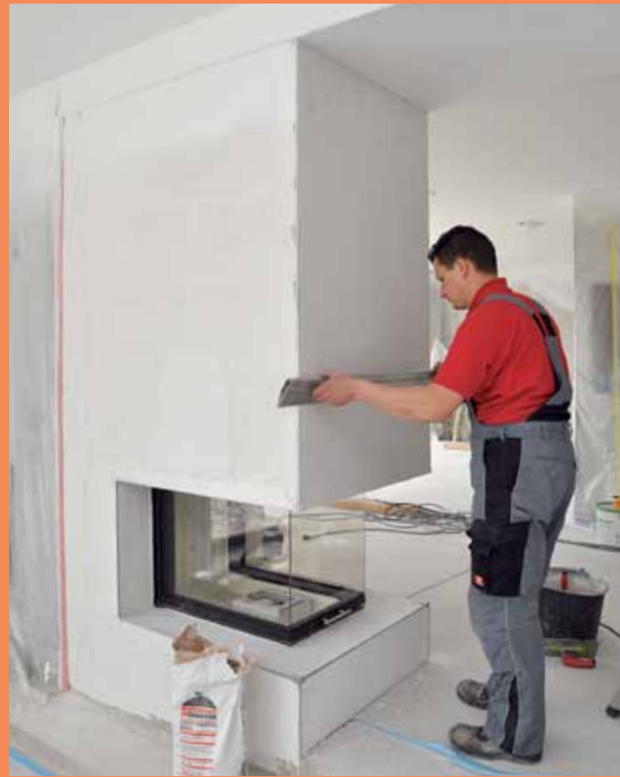
26. Auf die gesamte Außenhülle wird noch einmal eine Lage feinkörniger Ofenputz aufgetragen und glatt abgezogen. Später erfolgt dann noch ein Farbanstrich.
