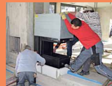
5. Die 375 Kilogramm schwere Brennzelleinheit wird an ihrem Bestimmungsort aufgestellt.
