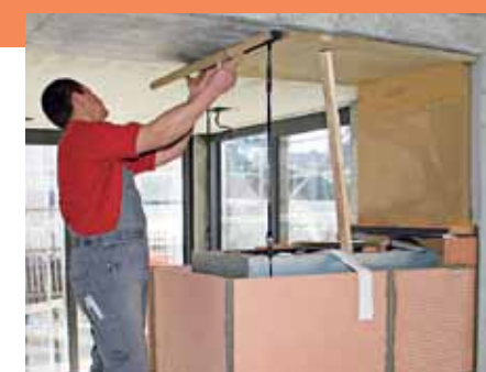
16. ... Spannvorrichtung des systemeigenen Tragrahmens der Brennzelle eingehängt.
