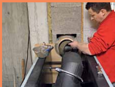
13. Danach verklebt der Ofensetzer das Stahl-Doppelwandfutter mit dem Keramikstutzen.
