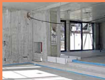
2. Fertiggestellter Sockel im Estrichumfeld: Er weist die Außenmaße der Kaminanlage auf.
