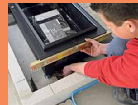
6. Die Feinjustierung der Stellfüße erfolgt mit einer Wasserwaage und einem Gabelschlüssel.
