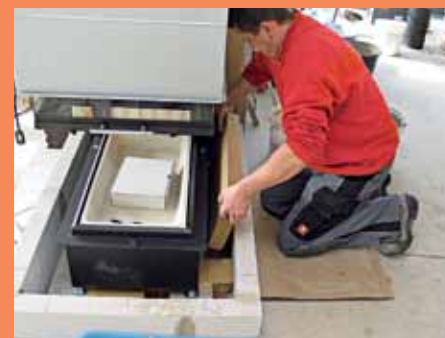
9. Auf gleiche Weise wird der Heizkammerboden (hier die Rohbetondecke zum Keller) gedämmt.
