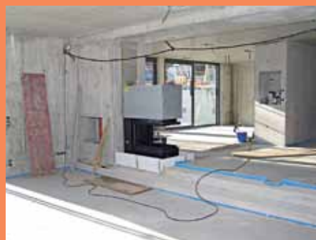
7. Die Brennzelle steht an Ort und Stelle und lässt schon den Gesamtraumeindruck erahnen.
