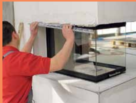
25. Um saubere, stoßfeste Kanten zu erhalten, kommen verzinkte Putzschielen zum Einsatz.
