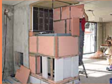
21. Die Ofenhülle aus Schwerschamotte-Platzträgerplatten wird bis zur Decke hochgezogen.
