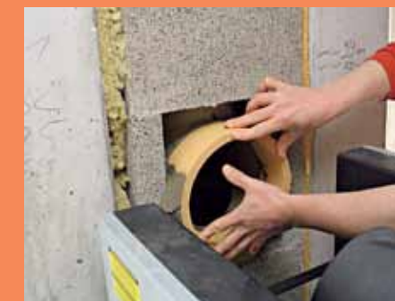
12. Der keramische Stutzen wird mit hitzebeständigem Mörtel am Schornstein angeschlossen.
