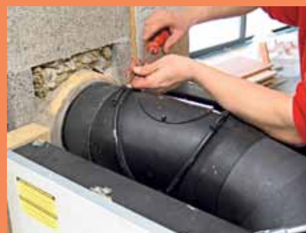
14. Schließlich wird das Rauchrohr mit dem Schornsteinanschluss fest verbunden.
