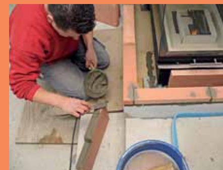
10. Passgenau geschnittene und mit Haftmörtel verklebte Schwerschamotteplatten bilden ...
