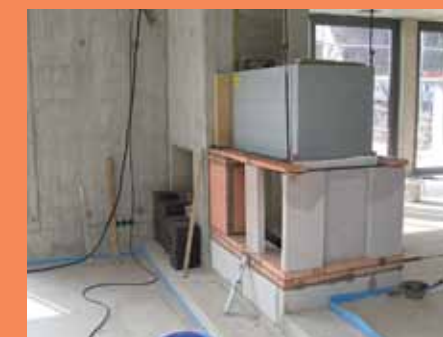
17. Später hängt hier die gesamte obere Kaminverkleidung aus Schamotte-Putzträgerplatten.
