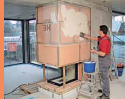
23. Zur Vermeidung von Putzrissen wird damit ein hitzeresistentes Gewebe einspachtelt.
