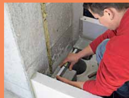
3. An vordefinierten Stellen werden Betonsteine platziert, auf denen die Brennzelle stehen wird.
