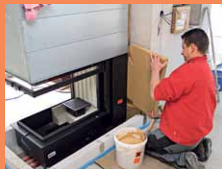
8. Um statisch belastete Wände zu schützen, werden Dämmplatten mit Spezialkleber eingebracht.
