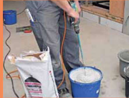
22. Dann wird der weiße, temperaturunempfindliche Feinputz (1 mm Körnung) angerührt.
