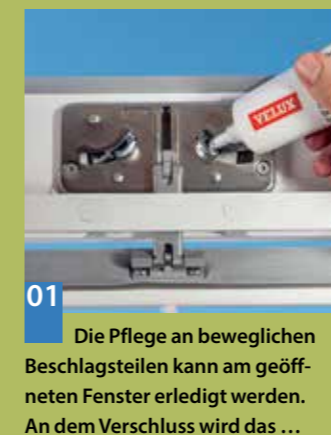
02 ... Scharnierfett aufgetragen. Auch das Gegenstück am inneren Fensterrahmen wird mit dem Scharnierfett gepflegt.
