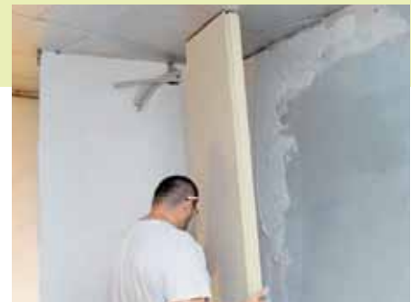
8. Dann das erste Dämmelement mit aufkaschierter Platte zuschneiden, senkrecht ausrichten und in den Kleber drücken.
