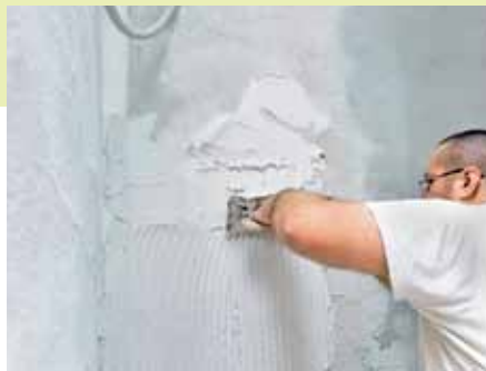
7. Dann kommen die Wände an die Reihe. Mit einer Zahnspachtel wird vollflächig Kleber aufgezogen, Unebenheiten dabei ausgeglichen.
