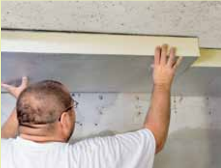
4. Die weiteren Dämmplatten werden jeweils dicht gestoßen ebenso kleberfrei verbaut und mit Haltekrallen fixiert.
