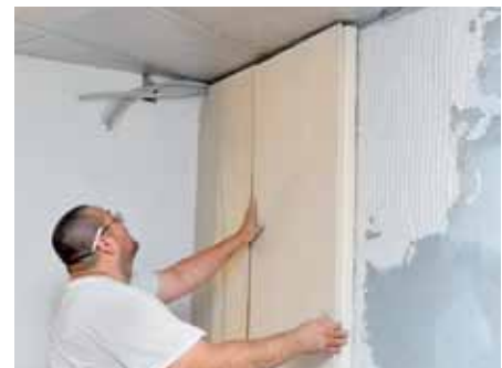
10. ... mit Rahmenschrauben befestigen. Danach Kleber vorlegen und das nächste Element über die Feder schieben und andrücken.
