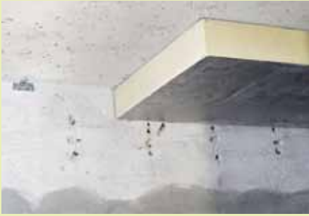
1. Zuerst wird die Decke gedämmt. Längs der Wand oben im Eck die Haltekrallen befestigen und die Dämmelemente in die Krallen drücken.
