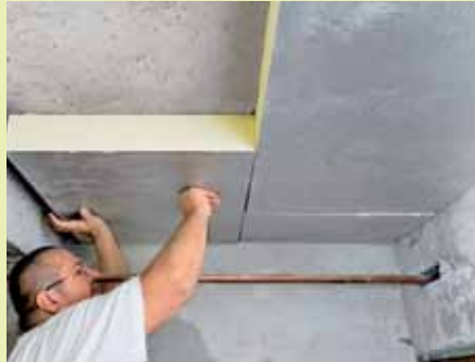
5. Jeweils also die PU-Dämmelemente in die Befestigungskralle des vorherigen Längsstoßes drücken.
