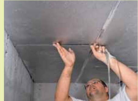
6. Zum Schluss sämtliche Stöße der Deckendämmplatten sowie die Wandanschlussfugen mit einem Alu-Klebeband abkleben.
