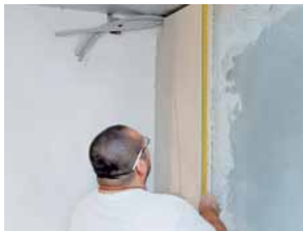
9. Eine Sperrholzfeder in den Längsstoß stecken. Nach dem Abbinden des Klebers das Dämmelement ...
