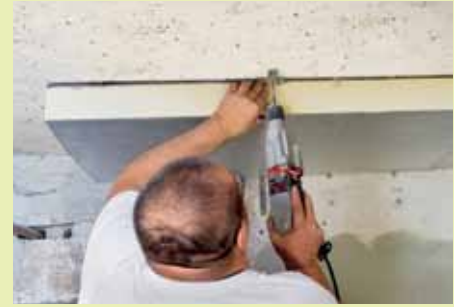
3. ... Zimmerdecke anzeichnen, vorbohren, einen Dübel setzen und anschließend die Metallkralle anschrauben.
