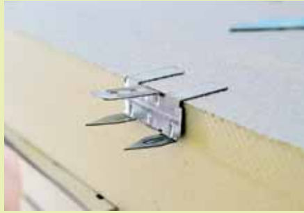
2. Zur Fixierung der Dämmplatte eine Befestigungskralle in die vordere Plattenkante eindrücken, Schraubloch der Kralle an der ...
