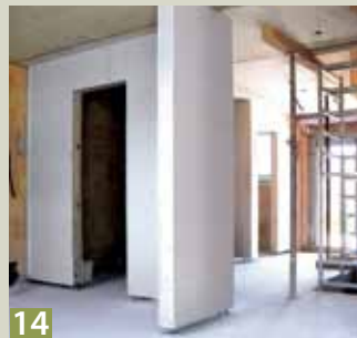
10 ... erforderliche Maß und setzt einen zusätzlichen Tragpfosten mit Überstand in das aufgeschnittene Element ein.
