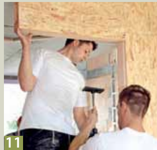
07 Dann wird das nächste Element mit seiner offenen Nutseite gegen den hervorstehenden Tragpfosten des ...
