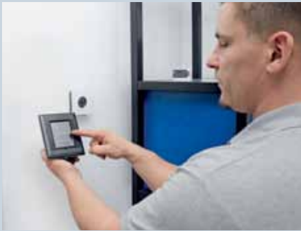
16. Entscheidender Schritt: Einlesen jedes einzelnen Thermostats via Funk in das Zentralgerät. Hier im Bild ist es der Raumthermostat.
