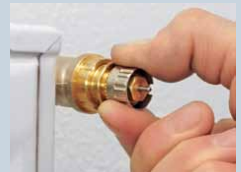
6. Die vom Berechnungsprogramm ermittelte Wasserdurchflussmenge für diesen Heizkörper (hier Wert „4“) wird nun am Ventil eingestellt.
