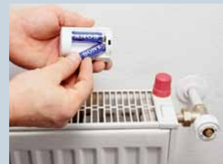
10. Dann werden die beiden mitgelieferten Mignon AA-Batterien in den Funkthermostat eingelegt, mehr braucht er nicht zum Betrieb.
