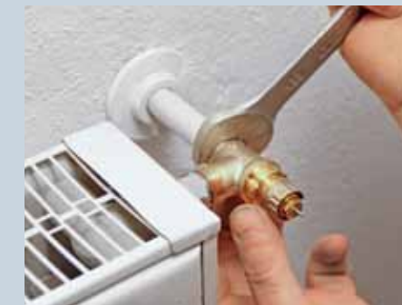
5. Per Maulschlüssel wird das voreinstellbare Thermostatventil nun behutsam aufgedreht und in die passende Anschlussposition gebracht.
