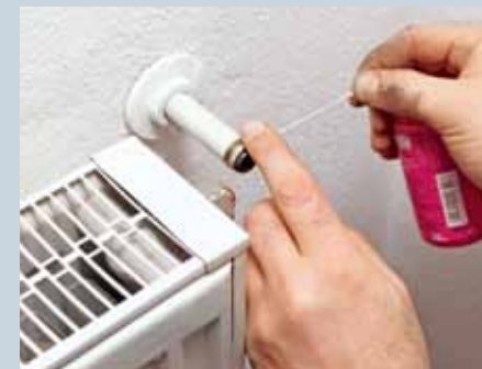
4. Nach wie vor bewährt ist das Abdichten des Gewindes mittels Hanf. Hierbei von außen nach innen im Uhrzeigersinn aufwickeln.
