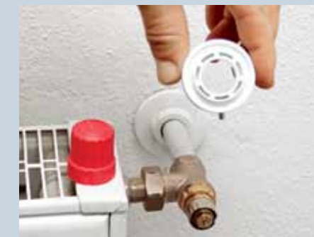
8. Ein spezieller Verbindungsadapter ermöglicht dann den Anschluss des jeweiligen Funkthermostats an nahezu jedes Thermostatventil.
