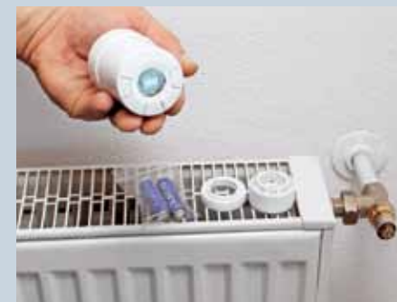
7. Modernste Technik: Via Z-Wave-Frequenzband (868,42 MHz) kommuniziert der batteriebetriebene Regler mit dem Zentralgerät. (s. Abb. 19)
