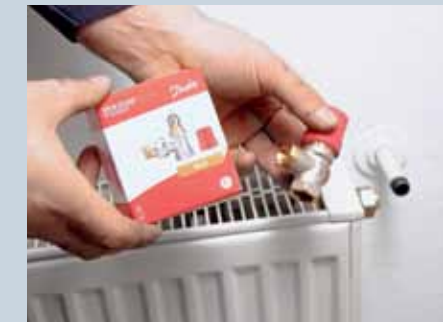
2. Die exakte Ausführung beziehungsweise Variante der neuen Ventile wurde zur jeweiligen Heizkörper-Bestandssituation ausgewählt.
