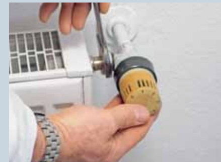
1. Erster Schritt zu mehr Energieeffizienz: Die Demontage der alten, nicht voreinstellbaren Thermostatventile inklusive der Thermostate.
