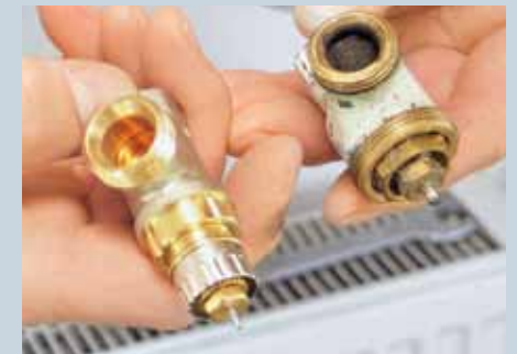
3. Das neue, voreinstellbare Thermostatventil (links) mit Zahlenskala, über das sich die maximale Heizwassermenge regulieren lässt.
