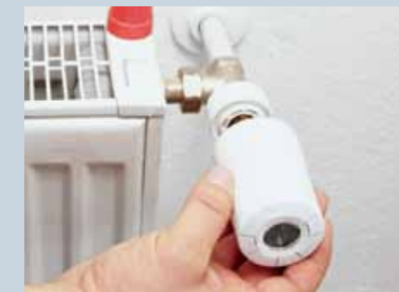
11. Durch einfaches Andrücken und Festdrehen per Hand rastet der Funkthermostat auf dem Ventiladapter ein und ist damit sicher fixiert.
