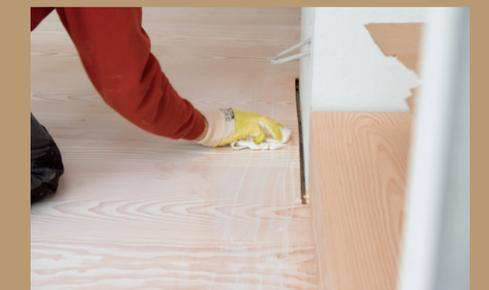
12. Nach frühestens 6 Stunden Trocknung wird die Seife in zwei Auftragsgängen aufgebracht.
