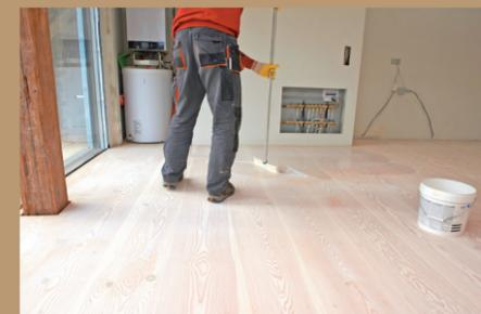
11. Die Lauge in Längsrichtung satt auftragen, überschüssige Lauge längs der Dielen abziehen.
