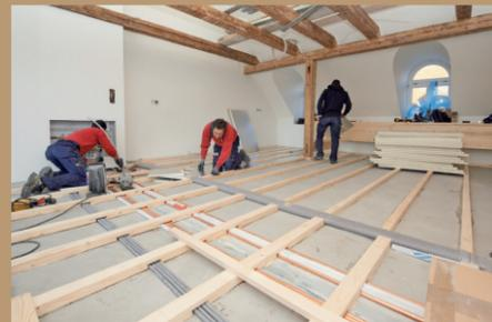
2. Da dieser verschraubt werden sollte, fertigte man eine entsprechende Holzunterkonstruktion.
