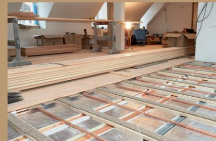
4. Die Dielen wurden sortiert, die Dämmelemente ausgelegt und die Rohre ...
