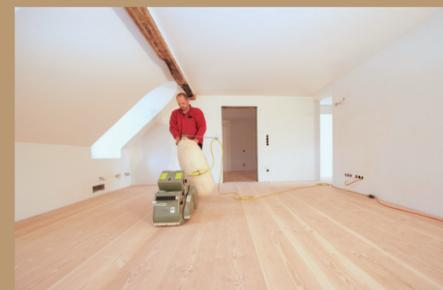
9. ... folgend eingeleimt worden, sind sie nach dem Abschleifen kaum mehr sichtbar.
