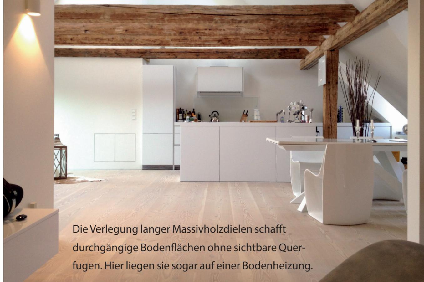
Die Verlegung langer Massivholzdielen schafft durchgängige Bodenflächen ohne sichtbare Querfugen. Hier liegen sie sogar auf einer Bodenheizung.
