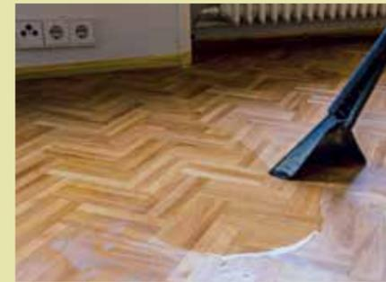
4. Das Holz wird richtig aufgeschwemmt, bis es aufquillt, bevor dann das Wasser bzw. das zugegebene Pflegemittel wieder abgesaugt wird.
