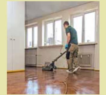
10. ... maschineller Unterstützung gearbeitet, damit sich die Wachse an der Oberfläche gut verdichten.
