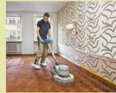
8. Eine Überarbeitung mit der Scheibenbürstenmaschine fördert das tiefe Eindringen der pigmentierten Lösung in die Holzporen.
