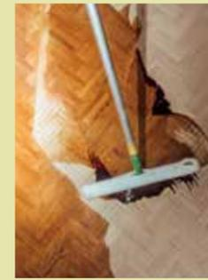
7. Hier wurde auf Wunsch eine dunkler eingefärbte Grundierung aufgebracht.
