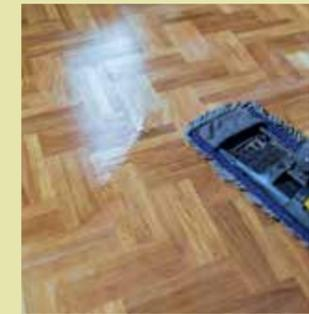
6. Die Pigmentlösung am Schluss füllt die Poren, das Holz wird so gleichmäßig faarbaufnehmend.
