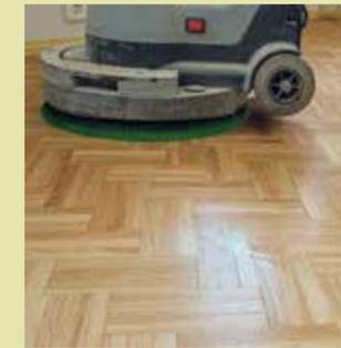
5. Mit einer Rotationsmaschine und speziellem Pad wird die Fläche immer wieder „zwischenpoliert“.
