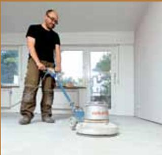
9. Nach Austrocknung sorgt eine schwere Tellerschleifmaschine für eine absolut plane Verlegefläche.
