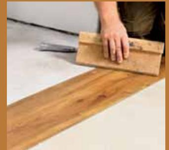
**14.** Vollflächigen Kontakt und Halt erhält die Vinylplanke nach dem Anpressen mit einem Korkreiber.
