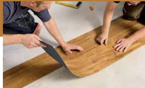
**19.** ... nächste Reihe entweder im halben Fugenversatz verklebt wird oder man den wilden Verband wählt, der mit dem Rest des letzten Passstückes beginnt.
