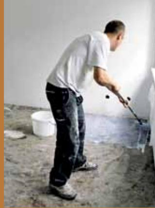
3. Mit einer Fellrolle lässt sich die Grundierung zügig auftragen. Der Boden ist schnell wieder begehbar.
