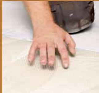
**12.** Verlegt wird erst, wenn der Kleber abgelüftet hat. Die Ablüfzeit wird per Fingerprobe geprüft.
