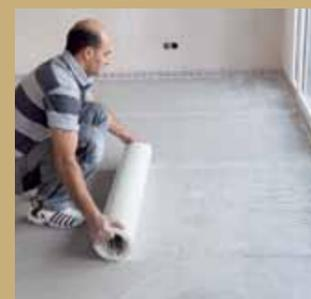
20. Nun folgt das Ausrollen und Auslegen des Glasgittergeleges. Zusammen mit der Grundierung ...
