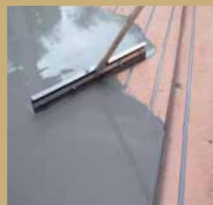
18. Für eine Schichtdicke von 3 mm wird der Verguss mit der Zahnrakel (Draufgänger) abgezogen.
