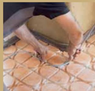
13. An den Biegungen wird das Rohr leicht vorgebogen und dann entsprechend eingeklipst.
