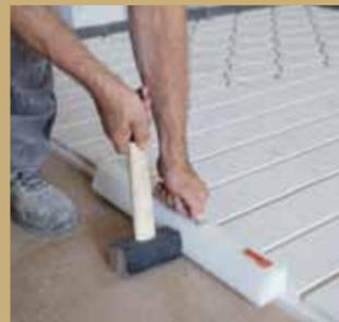
7. Die Platten werden per Fäustel und Verlegewerkzeug (Haudegen) dicht stoßend zusammengefügt.
