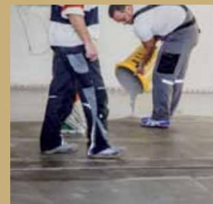
26. Anschließend wird die selbstnivellierende Masse auf der vorbereiteten Fläche ausgegossen.
