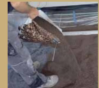
1. Zuerst wurde die Bodenplatte abgedichtet, dann die Ausgleichschüttung eingebracht.
