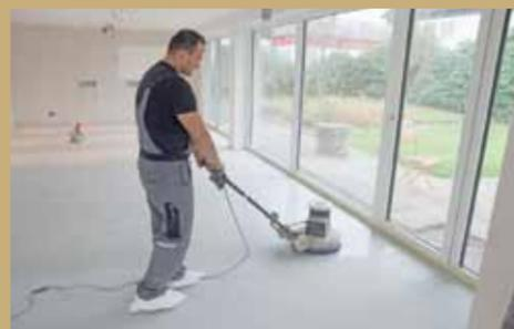
30. Das Vergüten der Oberfläche mit Hilfe einer Ein-teller-Schleifmaschine und speziellen Pads sorgt für eine ebene und elegant mattglänzende Oberfläche.
