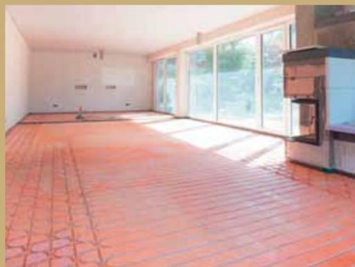
11. Die Grundierung ist rot eingefärbt, und die optimale Auftragsmenge kann mit einer Farbtafel kontrolliert werden.
