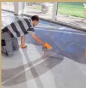
22. Die vergossene Grundierung wird mit einer kurzen Glättkelle verteilt, dann scharf abgezogen.
