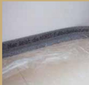
5. Darüber wird rundum ein Dämmstreifen mit Schleppfolie an den aufgehenden Bauteilen angebracht.
