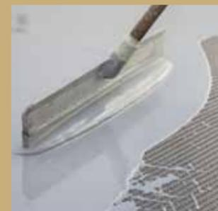
27. Mit einem Zahnrakel auf die entsprechende Höhe abziehen, mindestens jedoch 7 Millimeter.
