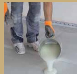
21. ... Okapox GF beugt die Armierung Schwund- und Spannungsrisbildung aus dem Untergrund vor.
