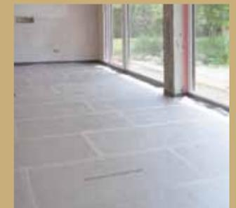
4. Die Stöße sind abgeklebt. Die ebene und tragfähige Unterkonstruktion ist fertig für die Heizung.
