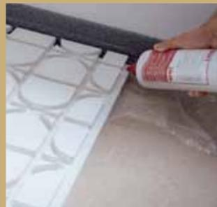
6. Nun werden die ausgefrästen Elemente verlegt und mit Systemklebstoff im Falzbereich verklebt.
