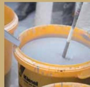
25. Die Bodenspachtelmasse wird mit einem Elektro-Rührgerät zirka 2 min. lang homogen angemischt.
