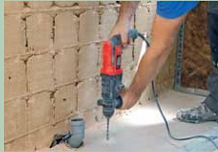
2. Die Befestigungspunkte für das Bodenprofil des Sanitäreinbauteils werden vorgebohrt.
