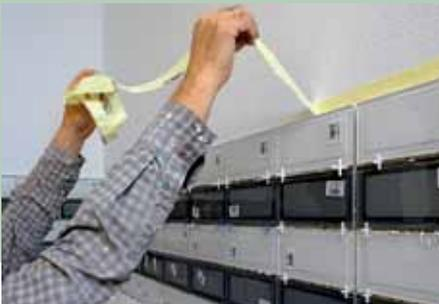
**21.** Sind die fünf Reihen Glasfliesen verlegt, wird das Band wieder abgezogen.
