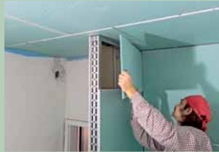
**11.** ... den faserverstärkten, imprägnierten Gipskartonplatten beplankt.
