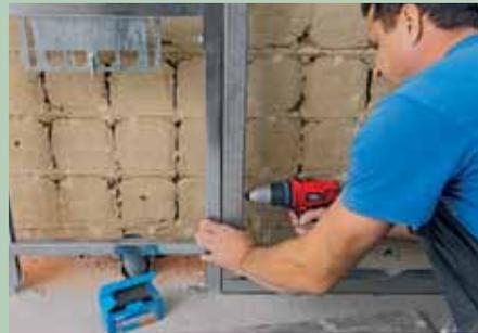
5. ... werden die waagerechten und senkrechten Profile mit den Sanitäreinbauteilen ...
