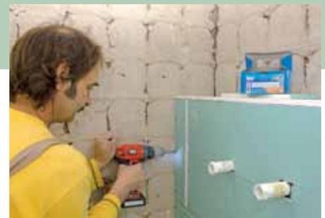
9. Mit Schnellbauschrauben wird die Beplankung an die Unterkonstruktion geschraubt.
