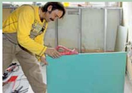
8. Die imprägnierten Ausbauplatten werden zugeschnitten, die Kanten glattgehobelt.
