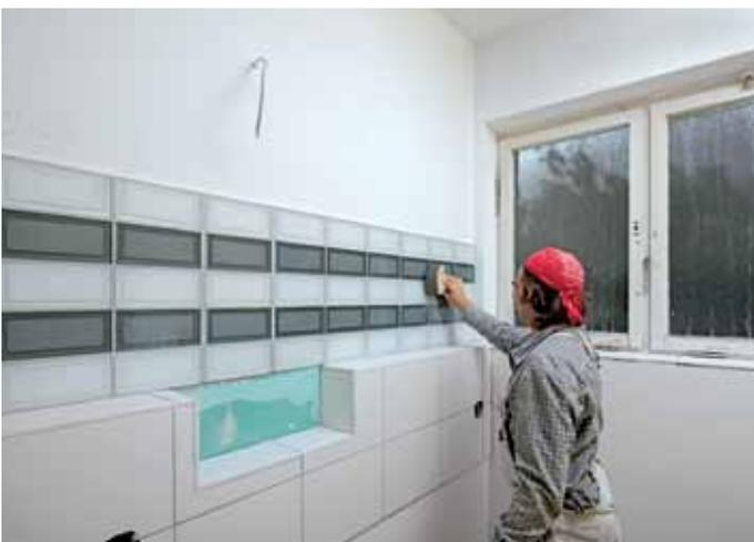
**24.** Sobald der Fugenmörtel auf dem Belag anzieht, wird der Mörtel auf den Fliesen mit einem angefeuchteten Schwamm vollständig entfernt.
