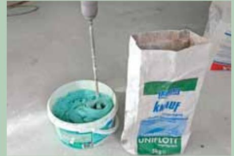
**12.** Zu den Platten passend wird ein wasserabweisender Spezialspachtel angerührt, ...
