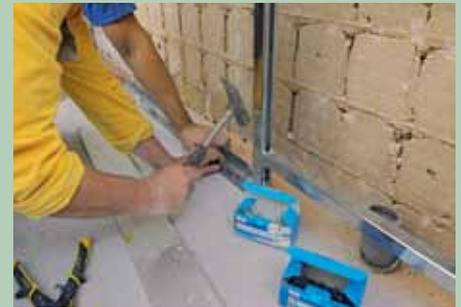
6. ... verschraubt und mit sogenannten Drehstiftdübeln im Fußboden fixiert.
