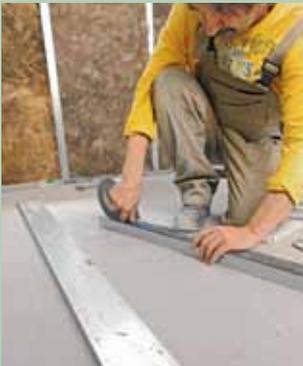
4. Die zugeschnittenen Bodenprofile beklebt man erst mit einem Dichtungsband, dann ...
