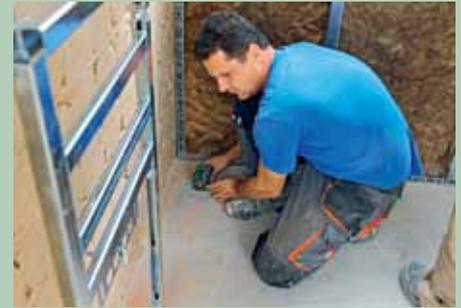
3. Mit Hilfe eines Lasers werden die Fluchten für die gesamte halbhohe Vorwand festgelegt.
