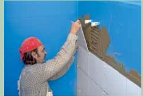
**15.** Anschließend werden erst die keramischen Wandfliesen mit Flexkleber verlegt.
