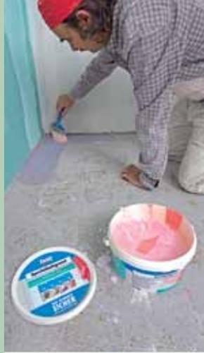
**14.** Zunächst wird der Boden grundiert, dann werden die Wände abgedichtet.
