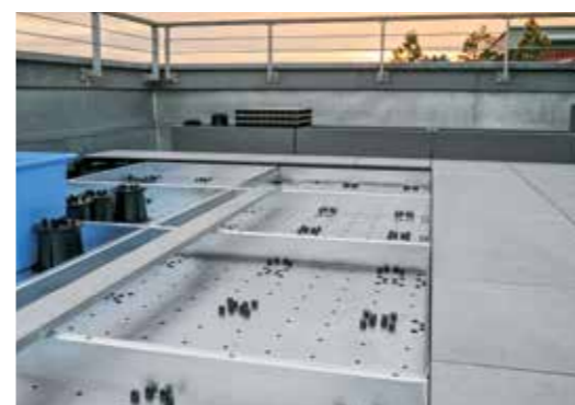
13. In den flachen Pflanzwannen wird Rollrasen verlegt. Um ein Einsinken beim Betreten zu vermeiden, muss der Boden gut verdichtet werden.
