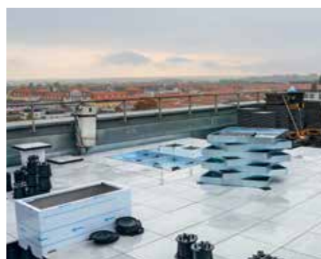
11. Die Fläche von 210 m 2 ist verlegt. Die Integration von Pflanztrögen, Pflanzwannen und anderen Systemelementen kann beginnen.
