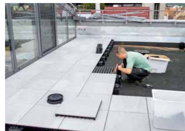
8. Immer wieder wichtig ist das exakte Ausnivellieren der Gitterroste. Auf das Fugenraster muss man nicht achten, das ergibt sich automatisch durch das System.
