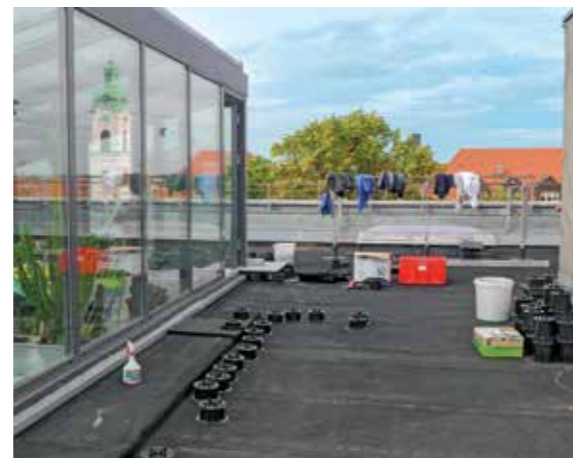
2. Die erste Plattenreihe wird vor dem Wintergarten verlegt, da hier ein Zuschnitt unschön wäre. Die Stelzlager lassen sich auf Flächenneigung und Niveaunterschiede einstellen.
