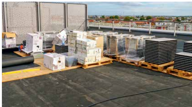
1. Die Anlieferung der Systemteile erfolgt auf Paletten, die mittels eines Krans auf die Dachterrasse transportiert werden. Zum Schutz des sanierten Unterbaus und der Abdichtungsschicht werden die Paletten auf Spanplatten gestellt.
