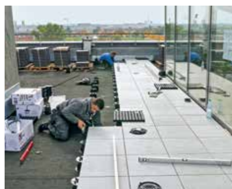
10. Noch einmal aus anderer Verlegeperspektive: Die Plattenreihen laufen parallel zur Hausfront und enden dann vor der Terrassen-Brüstung.
