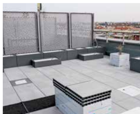
15. Zur Nachbarterrasse hin wird durchgehend eine Reihe Pflanztröge integriert, die dann noch mit Sichtschutzwänden bestückt werden.
