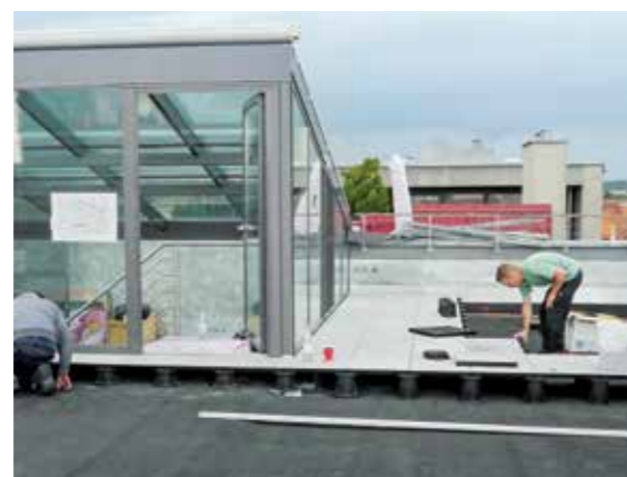
6. ... größere Fläche an – zunächst ohne weitere Systembauteile. Wenn die Fläche verlegt ist, lassen sich die entsprechenden Ergänzungen gemäß Plan am besten integrieren.
