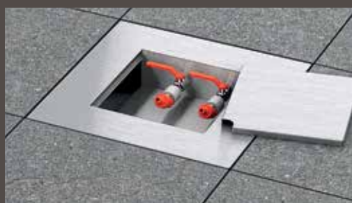
Technik elegant versteckt: Wer gut geplant hat, der hat dann dort Wasser und Strom, wo er es benötigt. Dennoch ist ein Versetzen auch später noch möglich.
