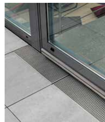
7. Damit vor den Terrassentüren ein sicherer Wasserablauf gewährleistet ist, werden Edelstahlgitter eingesetzt.
