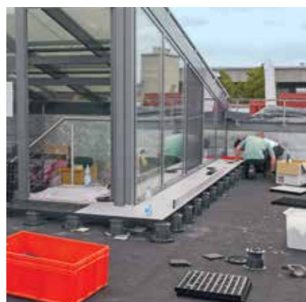
5. Die erste Gitterrostreihe ist nun bereits mit Belagsplatten ausgelegt und damit auch schon exakt ausnivelliert. Daran schließt sich eine ...
