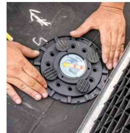
4. Hilfreich für den exakten Niveaueingleich der Stelzlager ist die integrierte Wasserwaage des sogenannten Buzon-Stelzlagersystems.
